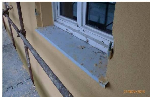
**FOTO 12 – 13 - Tamponamento laterale imbotte varco finestra e modifica davanzale con lamierino di adeguamento**
