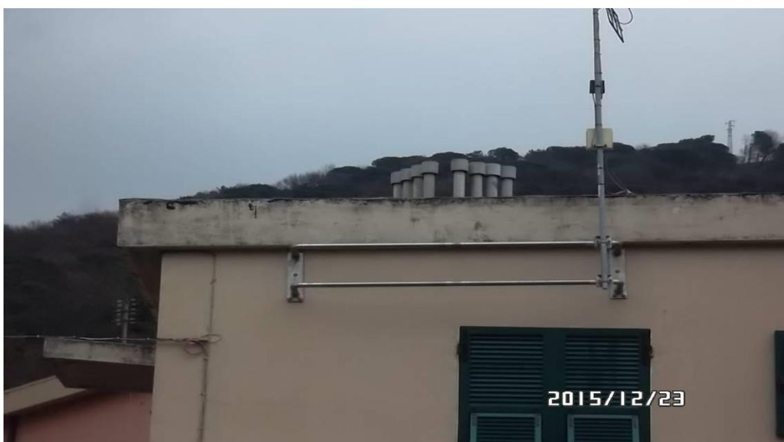
**FOTO 14 – 15 - 16** – Sostegni antenne Tv esistenti da smontare e ricollocare;
