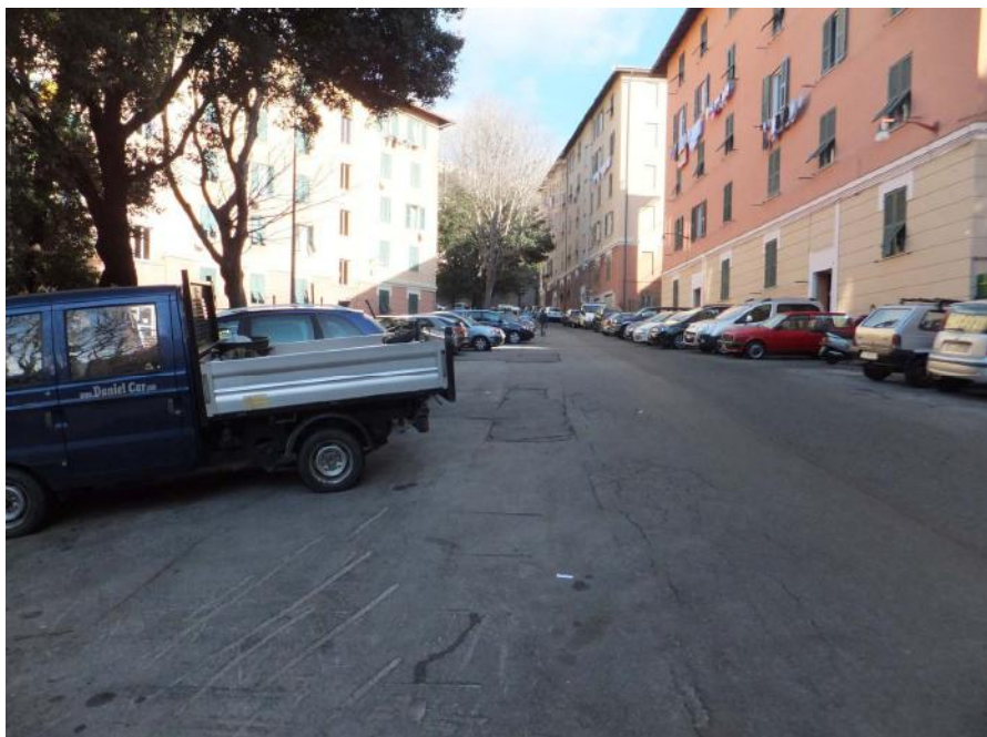
Foto 6 - Tratto stradale di via G. Casaccia privo di una rete di intercettazione dell'acqua piovana.
