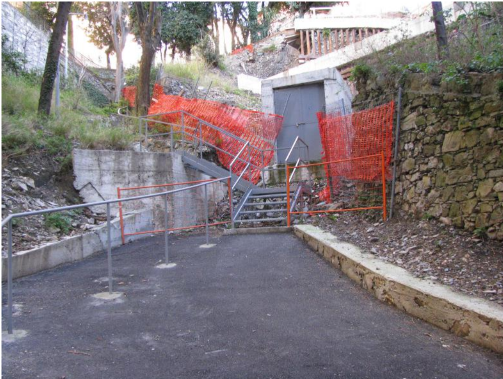
Foto 5 - Particolare della scala in metallo di collegamento con la preesistente rampa pedonale
