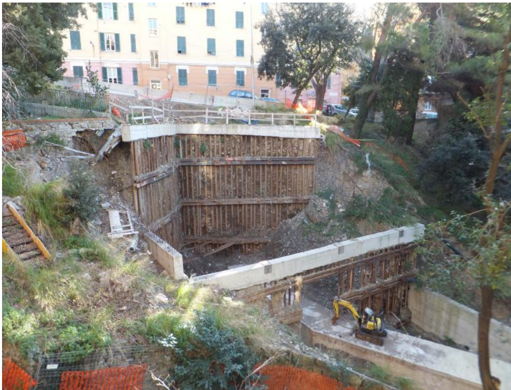
Foto 1 – Area interessata dall'intervento di messa in sicurezza del versante
