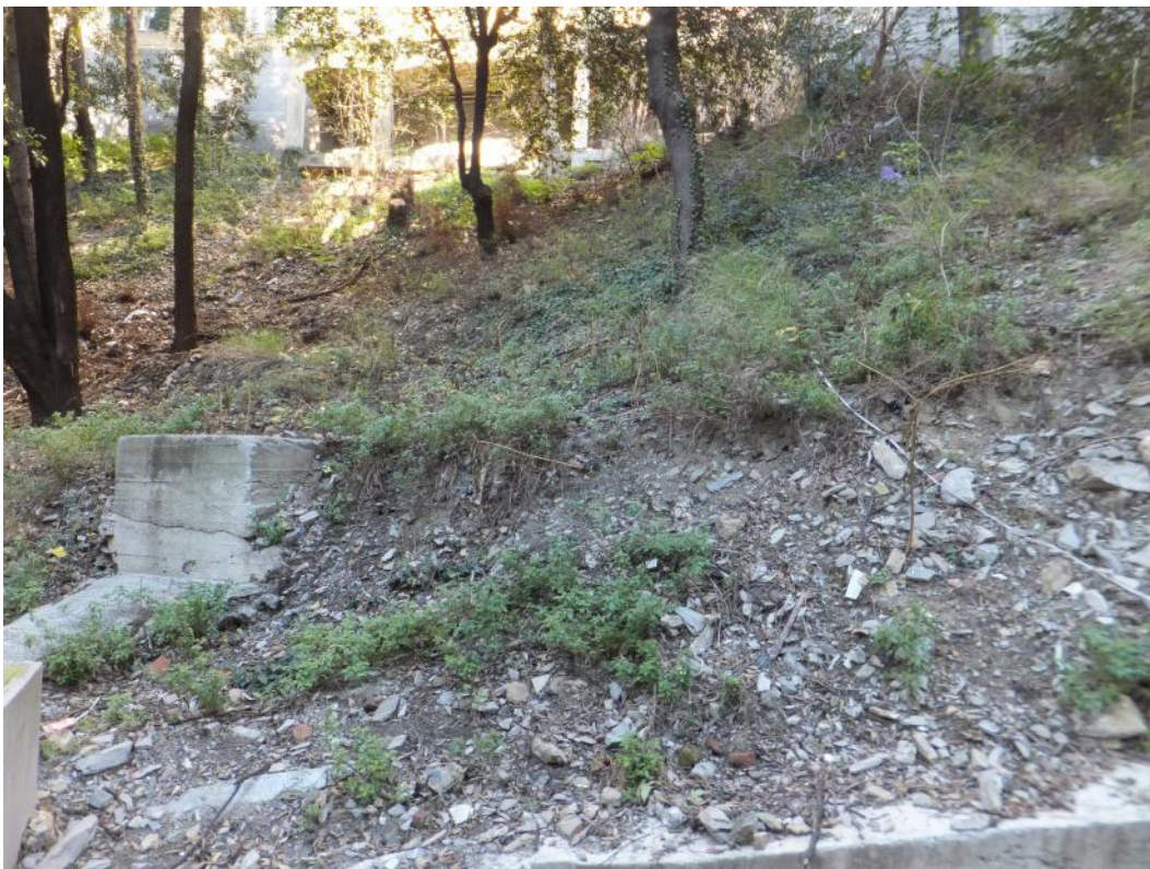
Foto 4 - Vista d'insieme della porzione di versante sinistro.
