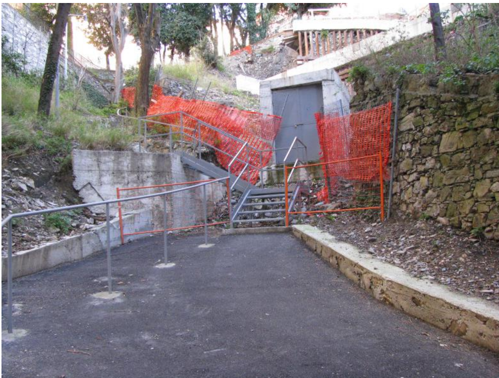
Foto 2 – Accesso al tunnel di ispezione della tombinatura del rio S.Ugo.
