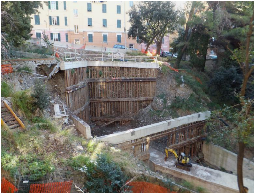
Foto 3 - Area interessata dall'intervento di messa in sicurezza del versante
