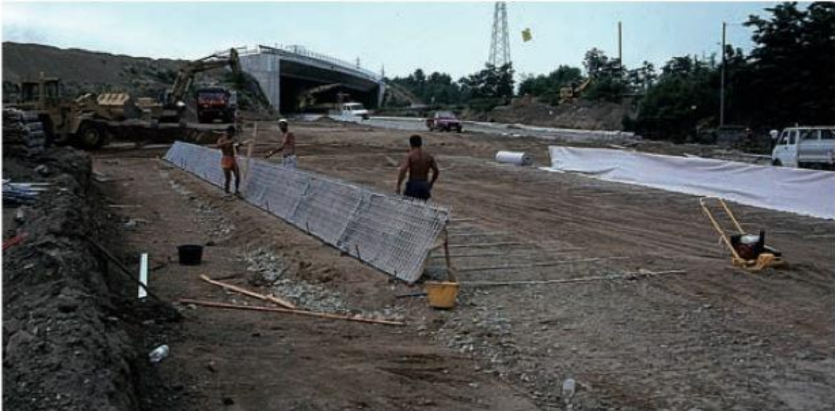
Figura 24 – esempio applicativo, posa e fissaggio del primo ordine di elementi.
