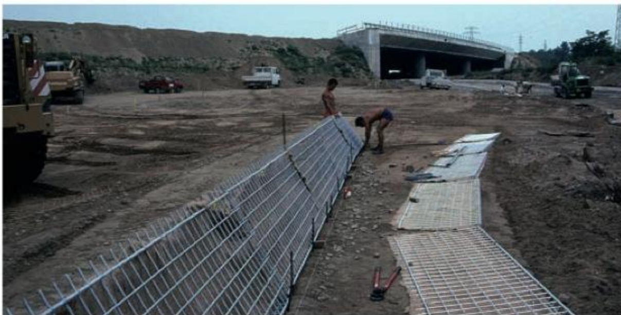
Figura 23 - Esempio applicativo, posa del primo ordine di elementi.
