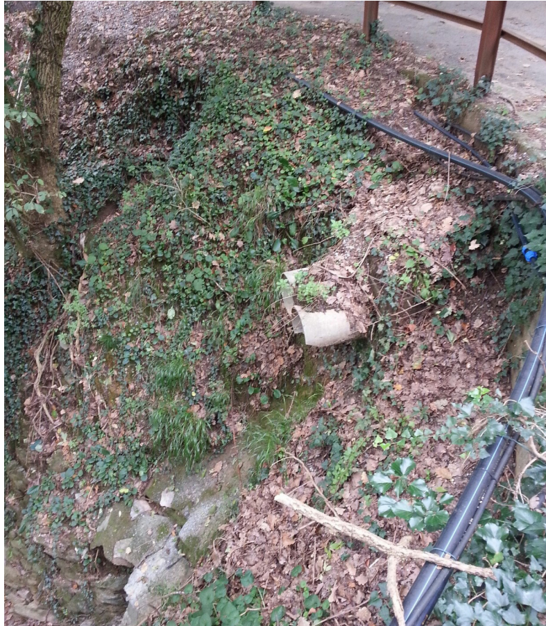
Foto 6 - tubazioni esistenti di convogliamento delle acque sotto strada.
