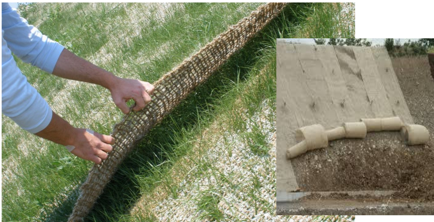
Foto 7 - Esempio applicativo: Particolare della biostuoia di fibra di cocco e attecchimento dell'idrosemina.
