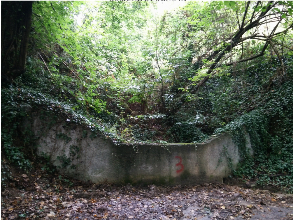
Foto 3 - Rio Razzara con relativa vasca relativa all'intervento n° 3.
