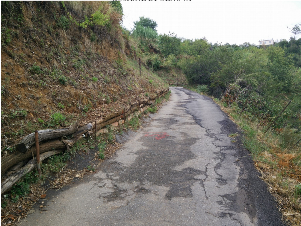
Foto 7 - opere di contenimento provvisorie proseguimento dell' intervento n°5
