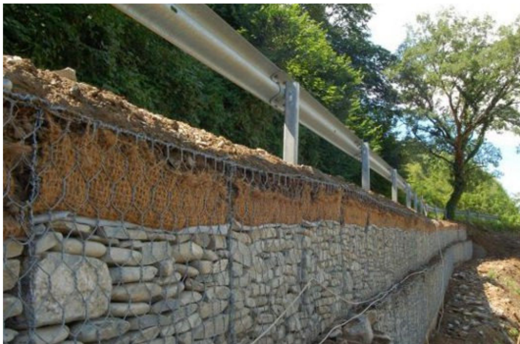
Foto 6 - Esempio applicativo: impiego dei gabbioni con tasca vegetativa come sostegno sottostradale, interventi n° 1 e 5.
