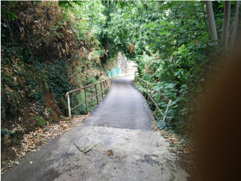
Foto 5 - ponte in cls armato con evidenti cedimenti strutturali intervento n°4.
