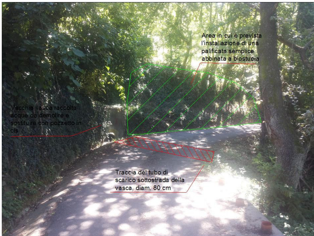
Figura 10 Intervento n.2 Vista della vasca raccolta acque e traccia del collettore di scarico sottostrada
