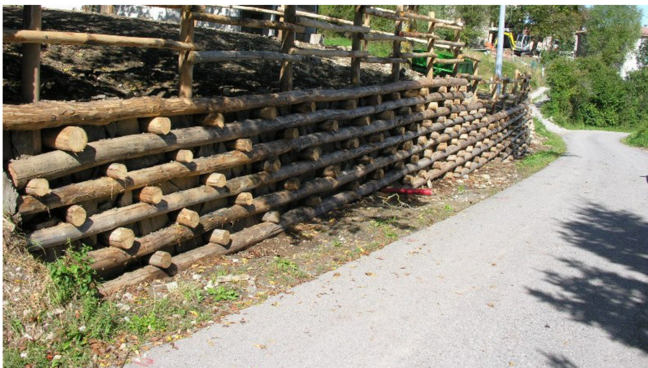
Foto 8 - Esempio applicativo: Palificata in legname.
