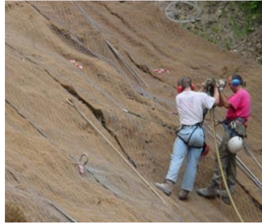
Figura 15 - Fasi di messa in opera
