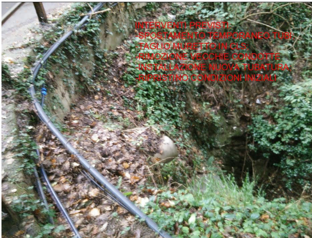
Figura 13 Intervento n.3, lato di valle, area di sbocco nuova condotta.
