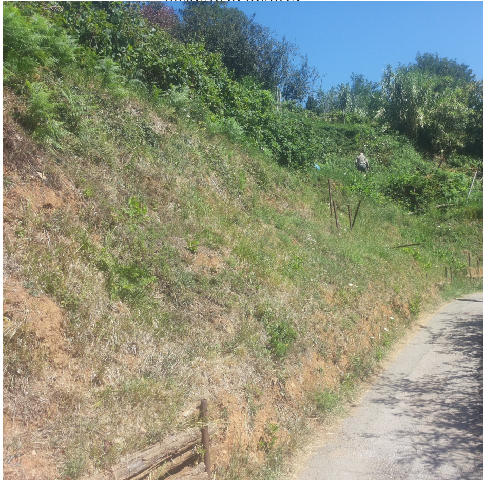
Figura 17 Intervento n.5 Palificata semplice
