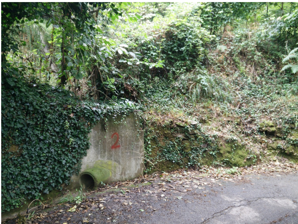
Foto 14 - vasca esistente a monte di Via Superiore Razzara relativa all'intervento n°2.
