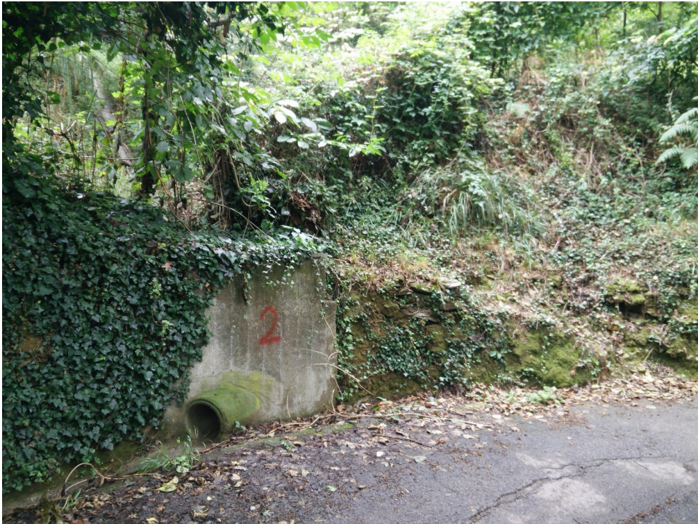
Foto 2 - Vasca esistente a monte di Via Superiore Razzara relativa all'intervento n°2
