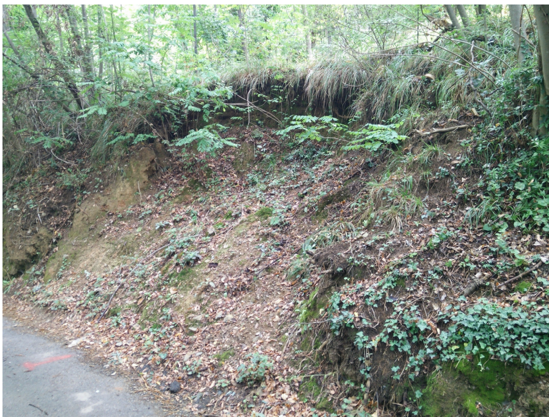
Foto 1 - la nicchia di frana a quota 206 relativa all'intervento n°1.
