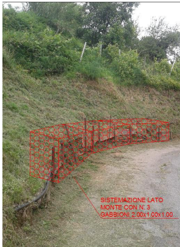
Figura 16 Vista della zona dove verranno installati i gabbioni
