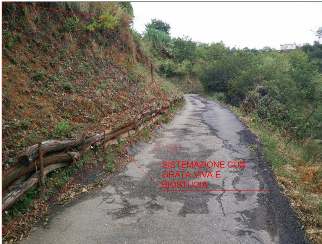
Figura 18 Immagine di un tratto di scarpata su cui si interverrà con una grata viva
