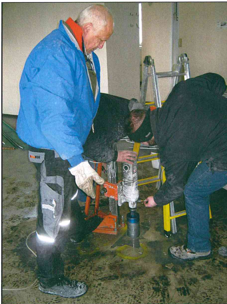
Figura 54: Esempio di esecuzione di carotaggio sugli orizzontamenti.
