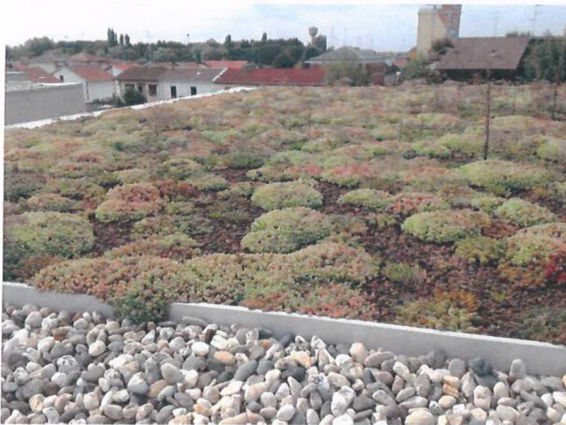
Immagine 2.6: esempio di copertura finita con ghiaia e verde pensile
