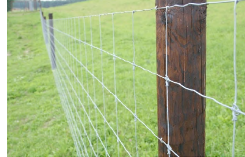
Recinzione in pali di legno e rete metallica per aree cani
