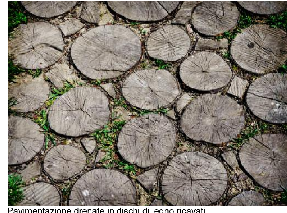
Pavimentazione drenate in dischi di legno ricavati dal taglio selettivo delle essenze presenti nell'area
