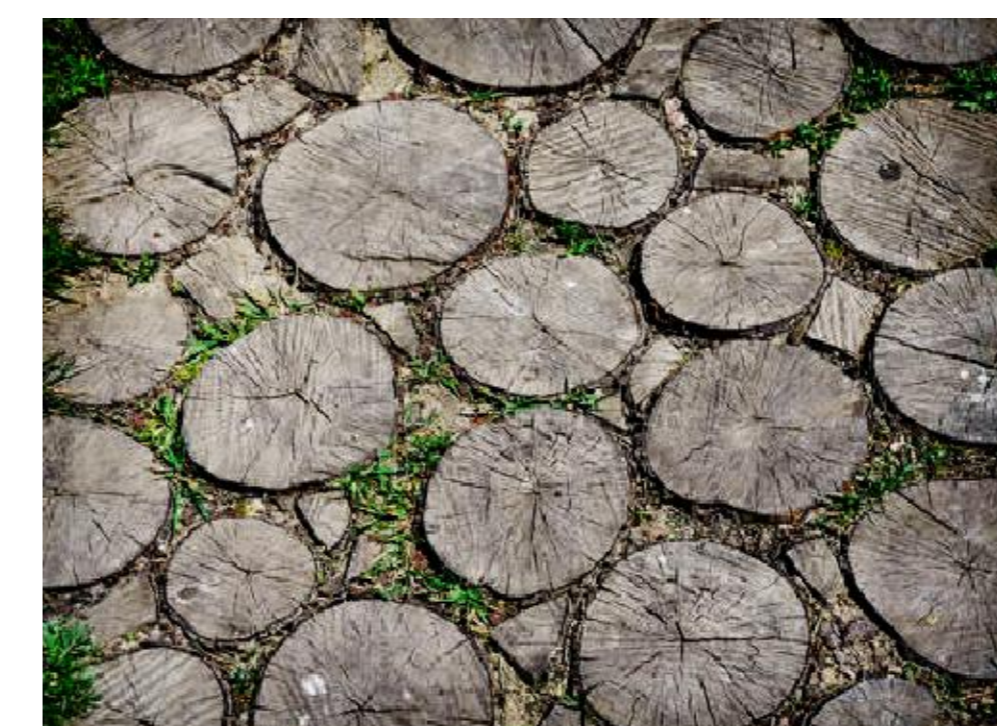
Pavimentazione drenante in dischi di legno ricavati dal taglio selettivo delle essenze presenti nell'area
