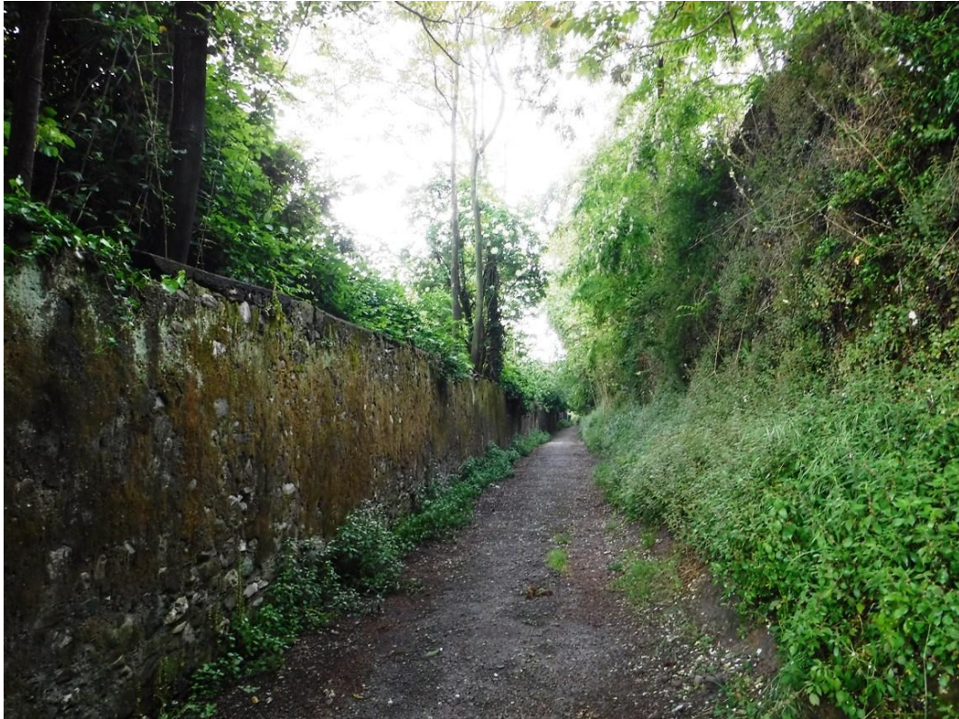
Fig. 5 - Strada carrabile che attraversa la tappa di attraversamento.
