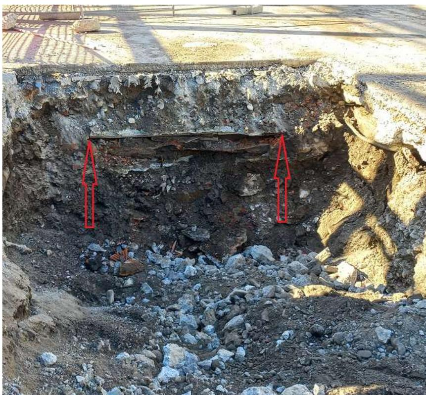
Considerato che è necessario proseguire con urgenza lo scavo, per una lunghezza totale di circa 40 m e larghezza 2 m, per un totale di 80 m<sup>2</sup> circa e che l'impresa in cantiere metterà a disposizione mezzi e uomini per la rimozione degli strati sovrastanti il MCA fino alla sua messa a giorno senza movimentare lo stesso, all'interno delle prestazioni di cui trattasi si chiede all'operatore di:
