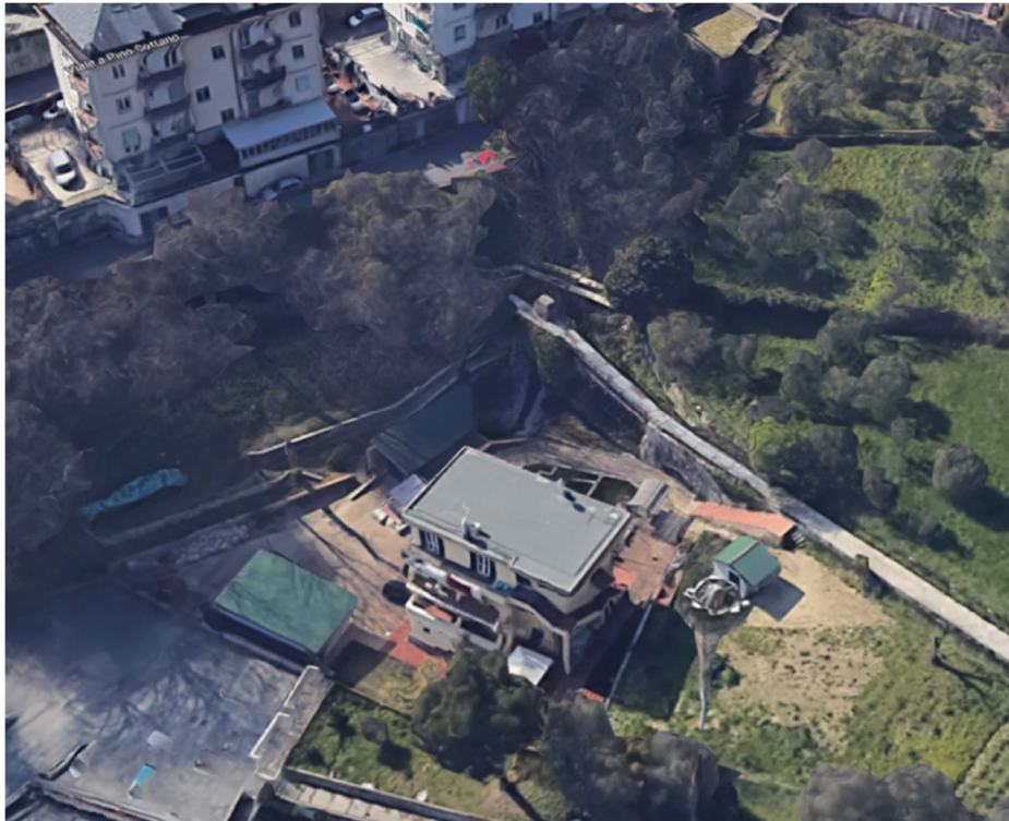
Figura 6 – Vista aerea zona di intervento
