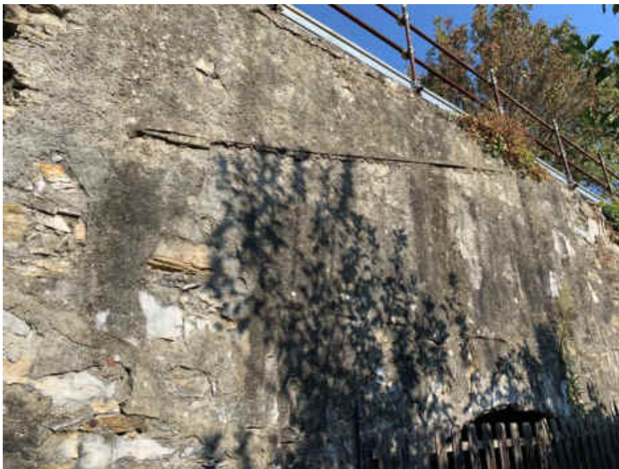
Foto 18 – Particolare rivestimento murario con rinzafo cementizio in zona Ca' de Rissi
