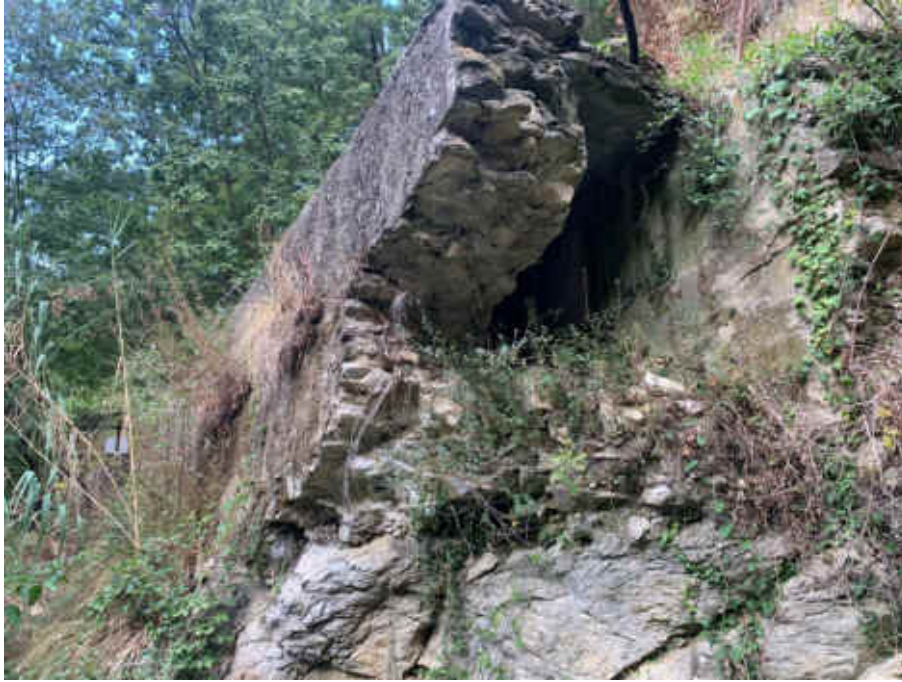
Foto 9 – Particolare moncone lato Trensasco
