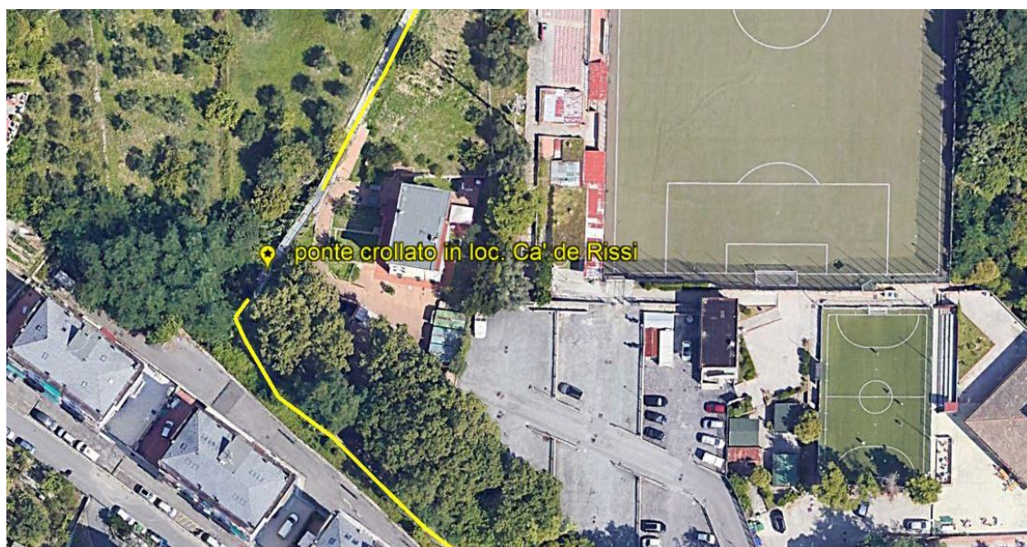
Localizzazione del ponte provvisorio in loc. Ca' de Rissi.
