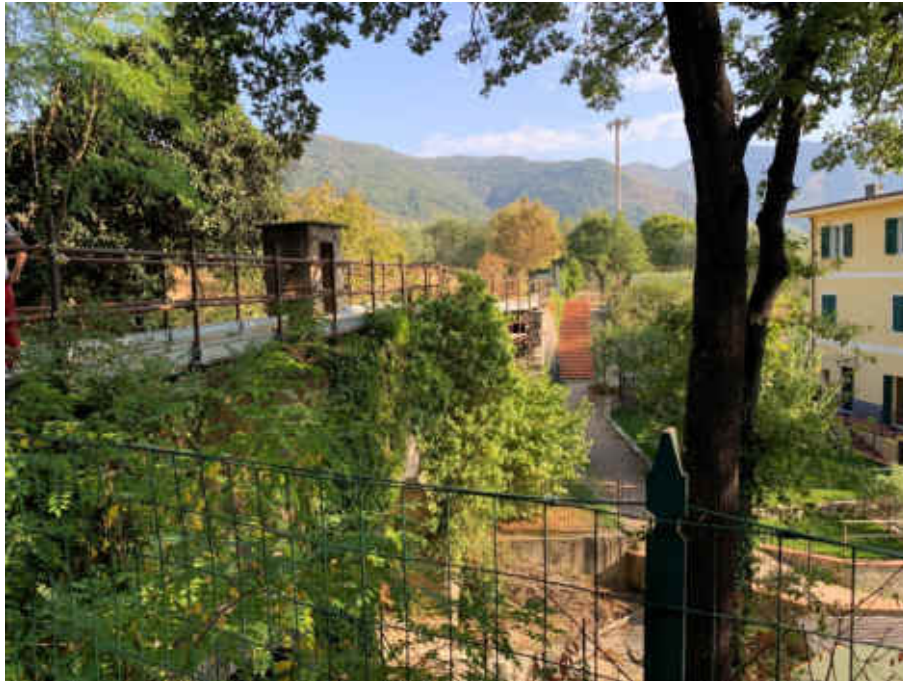
Foto 12 – Passerelle metalliche provvisorie sul ponte in località Ca' de Rissi
