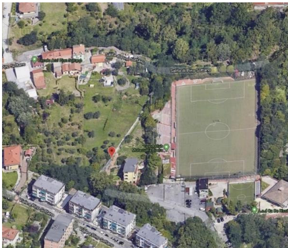
Figura 5 – Vista aerea zona di intervento
