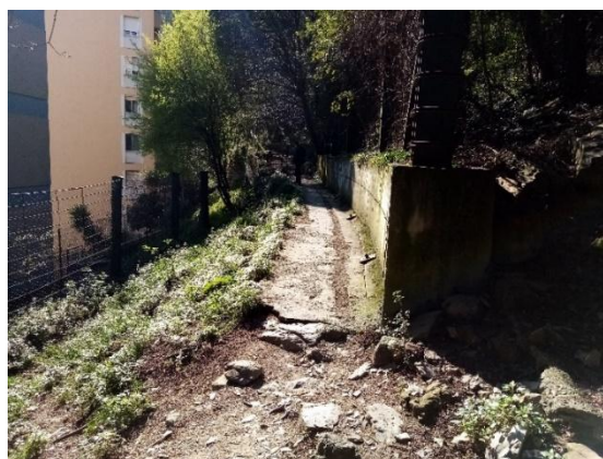
Vista del muro in c.a. tirantato e delle barriere paramassi.
