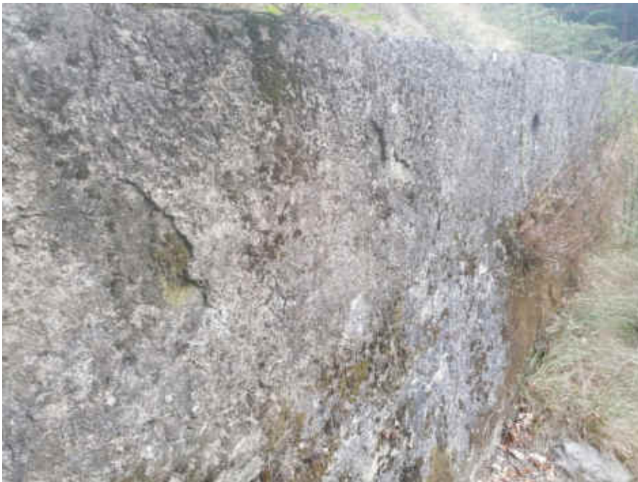
Foto 10 – Particolare rivestimento murario con rinzafo cementizio
