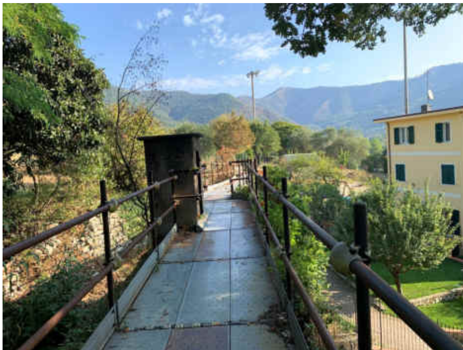
Foto 13 – Particolare impalcato in passerelle metalliche provvisorie
