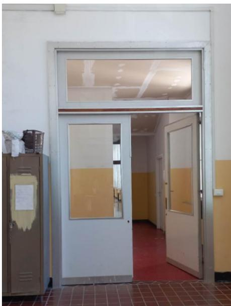
**Figura 6.** Varco da sostituire al piano prima con porta tagliafuoco con relativa necessità di tamponare il sopraluce.
