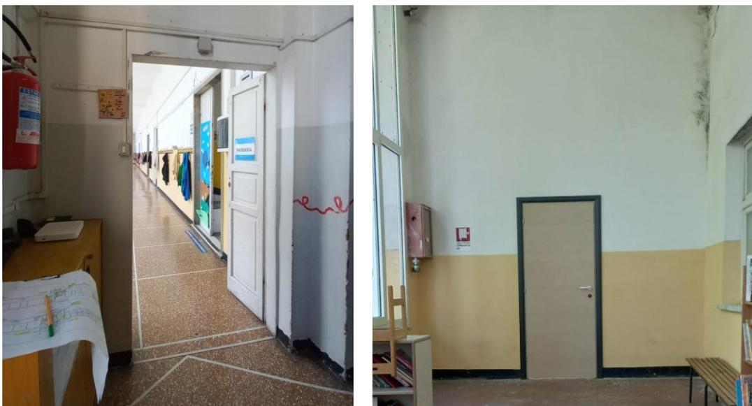
**Figura 5.** Varchi da allargare al piano primo per inserimento di porte tagliafuoco: porta di accesso tra scala e corridoio aule scuola primaria (sinistra); porta di separazione tra corpo scuola e l'edificio ASL (destra).
