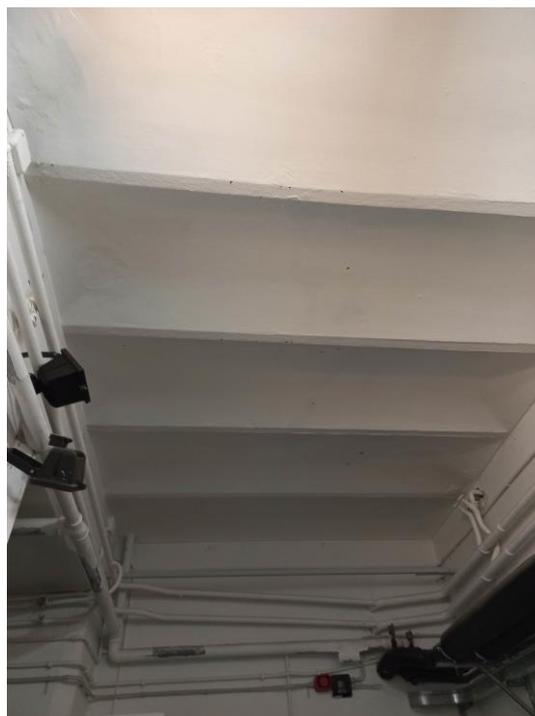
Foto **15 – 16** Interni dettaglio ingresso magazzino da atrio e dettaglio porzione solaio da tagliare per inserimento vano nuovo elevatore
