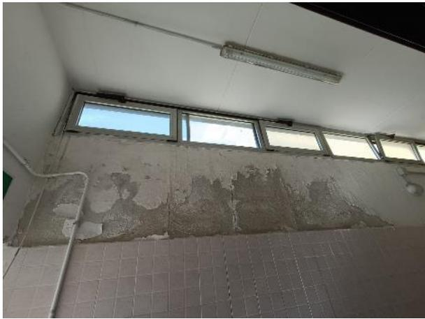
Pertanto, si prevede di eseguire il rifacimento dell'impermeabilizzazione della copertura piana del blocco, l'eliminazione dei torrini di ventilazione (già occlusi da tempo), ed il ripristino interno sia dei controsoffitti, mediante la sostituzione dei moduli in cartongesso ammalorati, e sia delle pareti interne. Si eseguirà contestualmente la revisione della tenuta degli infissi da cui percola acqua all'interno.
