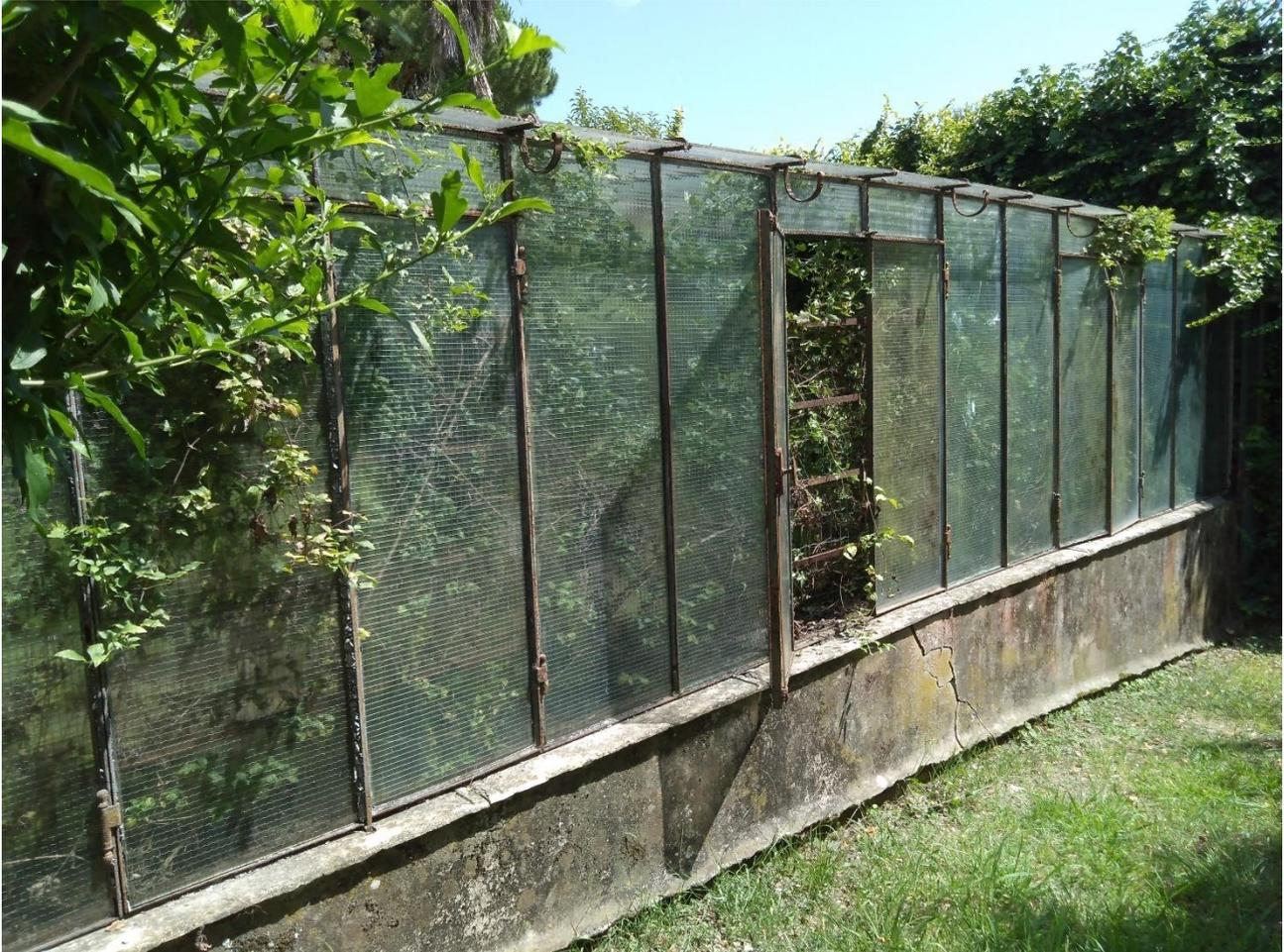
Serra1 (serra nord) dettaglio: si nota l'assenza totale della gronda
