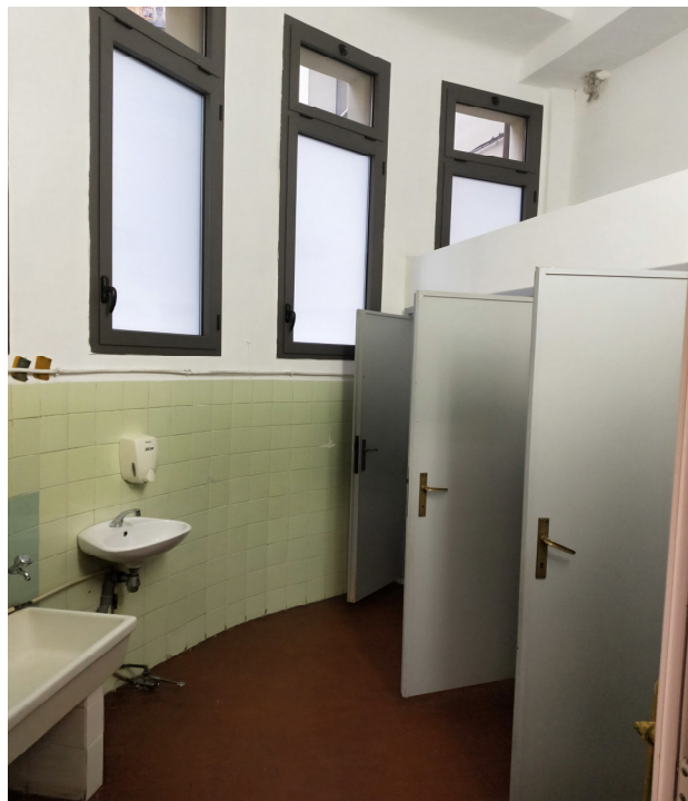
Foto 2 - Piano Terra – Interno servizi igienici Scuola d'Infanzia
