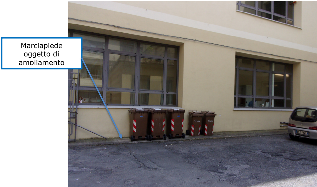
Foto 9 - Piano Terra – Cortile posteriore, ambito di realizzazione dei posti auto per disabili
