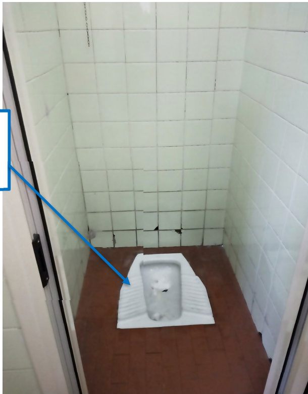
Foto 8 - Piano Primo – Servizio igienico tipo Scuola Primaria
