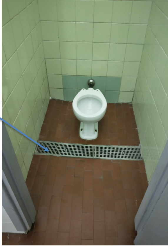
Foto 3 - Piano Terra – Servizio igienico tipo Scuola d’Infanzia
