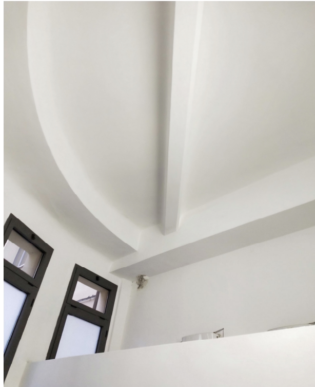
Foto 5 - Piano Terra – Cassettonatura scarichi del primo piano e allaccio alla colonna
