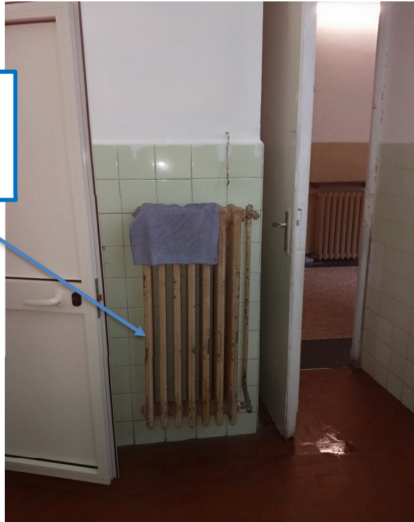
Foto 7 - Piano Primo – Interno servizi igienici Scuola Primaria
