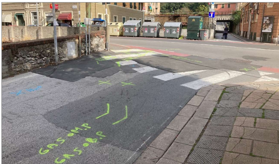
Figura 0-17: Vista dell'area a valle della spalla sud del ponte di via Canepari, con l'evidenza delle condotte del gas presenti a seguito del tracciamento eseguito da Ireti
