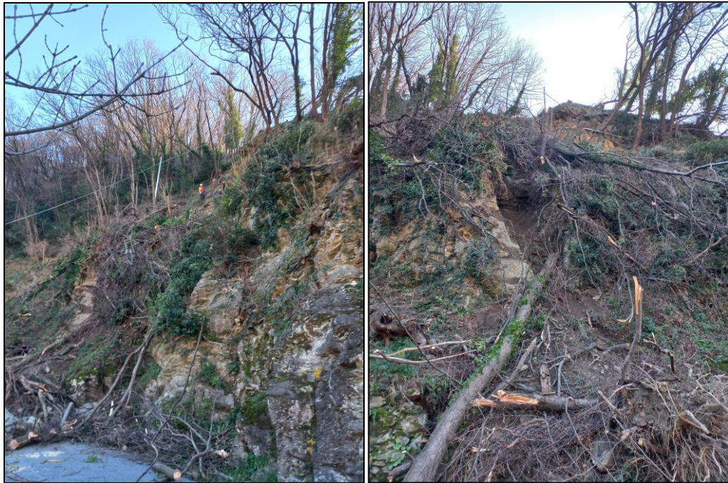
Figura 11: martedì 9 gennaio. Attività di disaggio e taglio piante in parete
