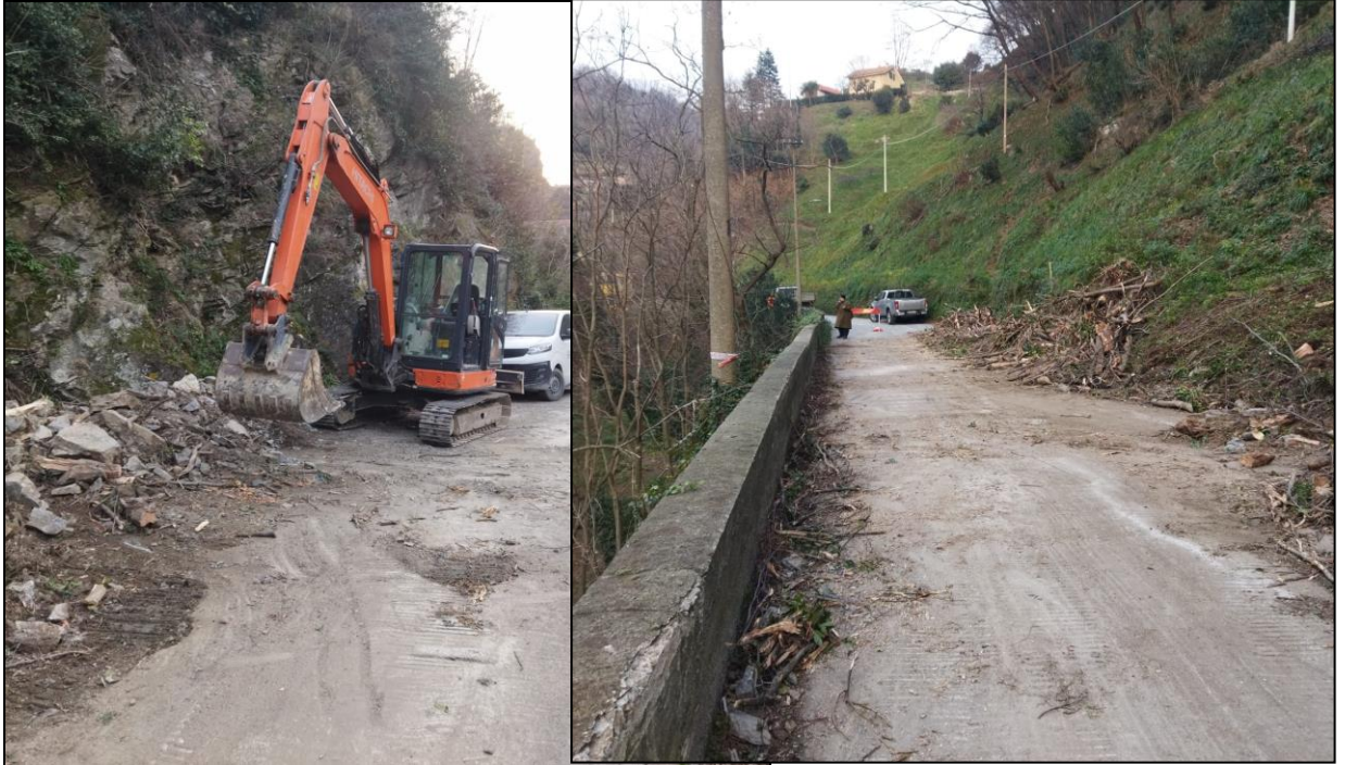
Figura 12: mercoledì 10 gennaio. Pezzatura piante e sgombero materiale in carreggiata
