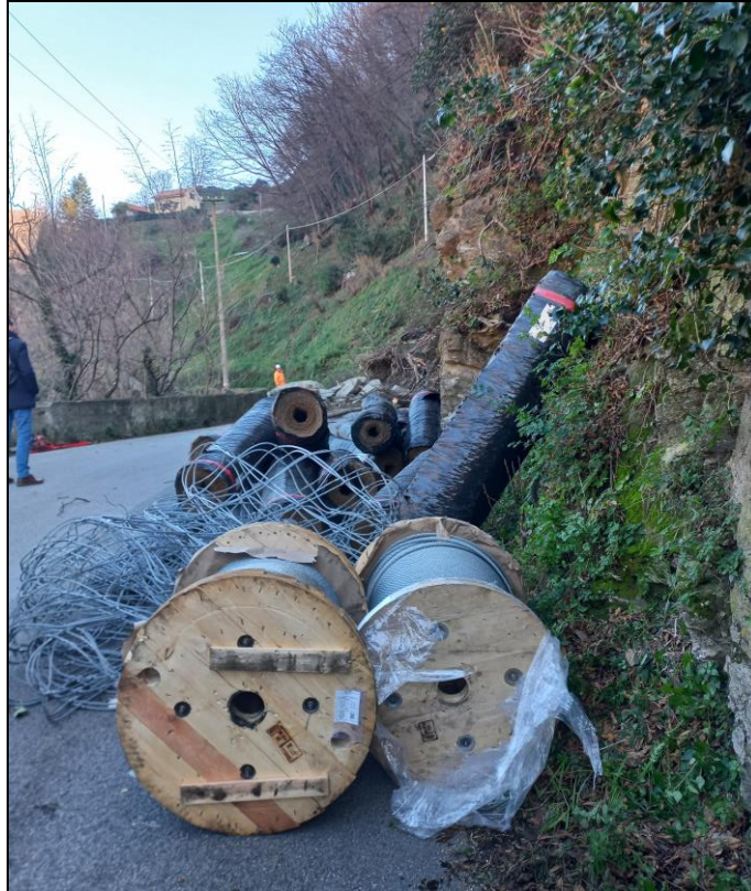
Figura 10: martedì 9 gennaio. Approntamento materiali per consolidamento parete
