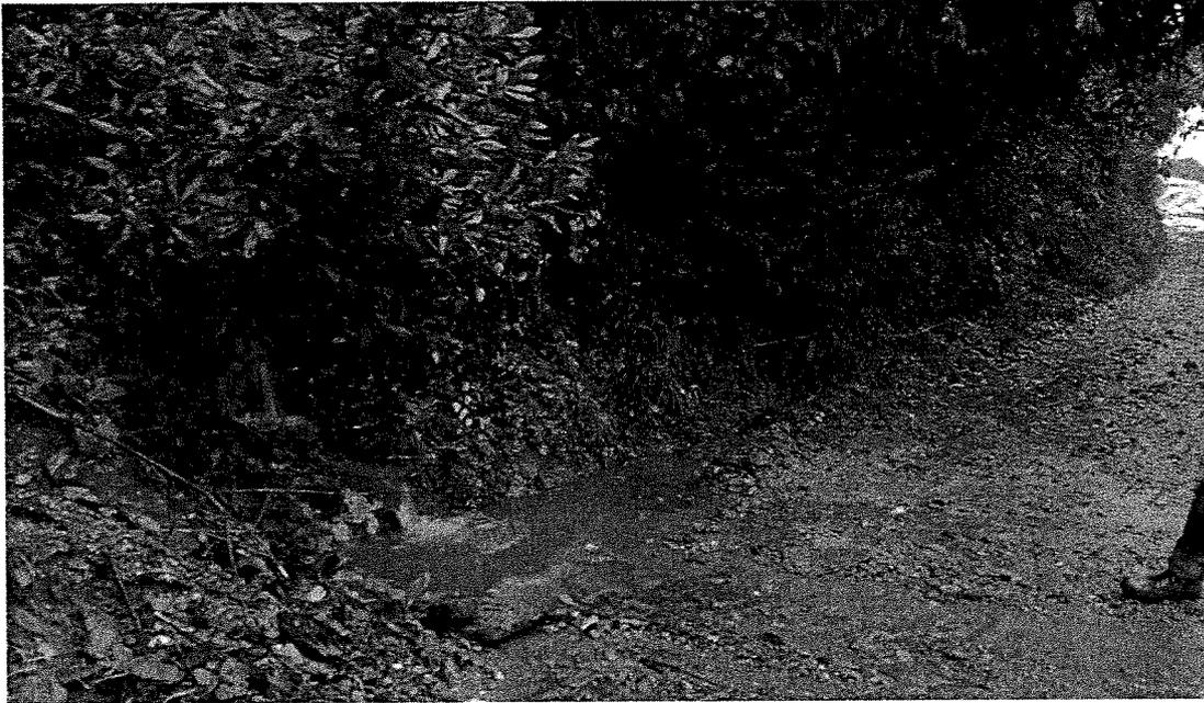
Figura5: Ostruzione del tubo drenante il colatoio in sponda sinistra del rio Pianego.
