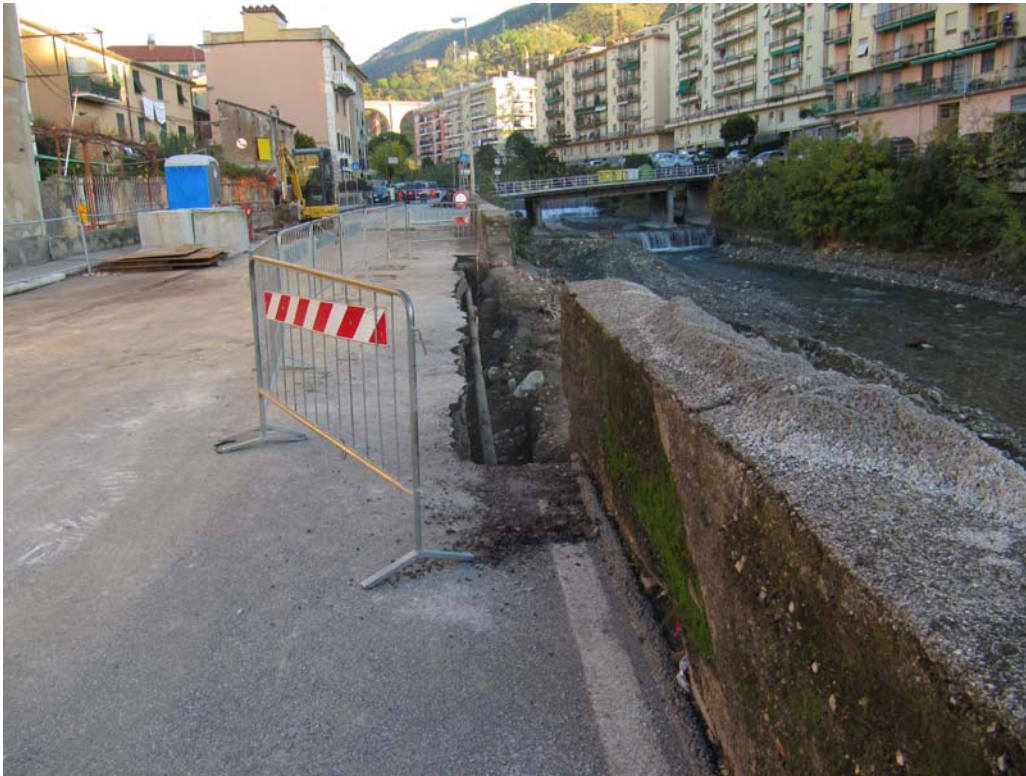
Fotografia n° 1 – Vista del tratto di muro oggetto d'intervento.
