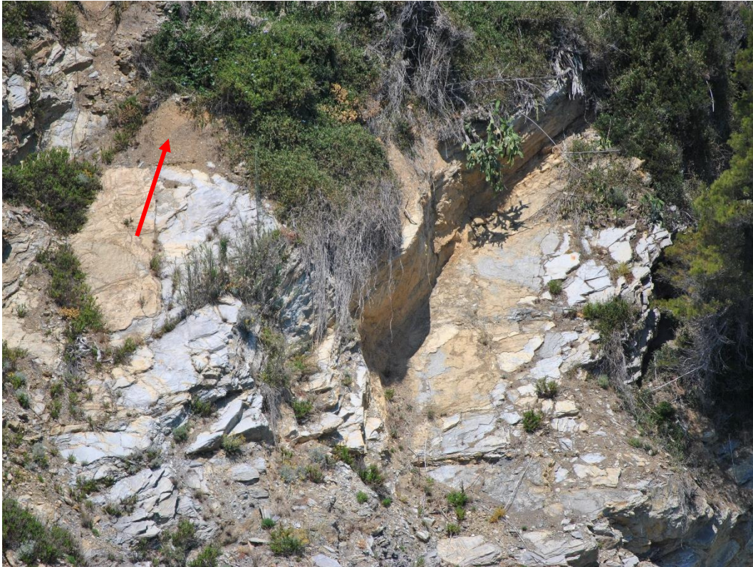
Foto 9: Pareti rocciose denudate. La freccia indica il materiale detritico ancora in precarie condizioni di stabilità.
