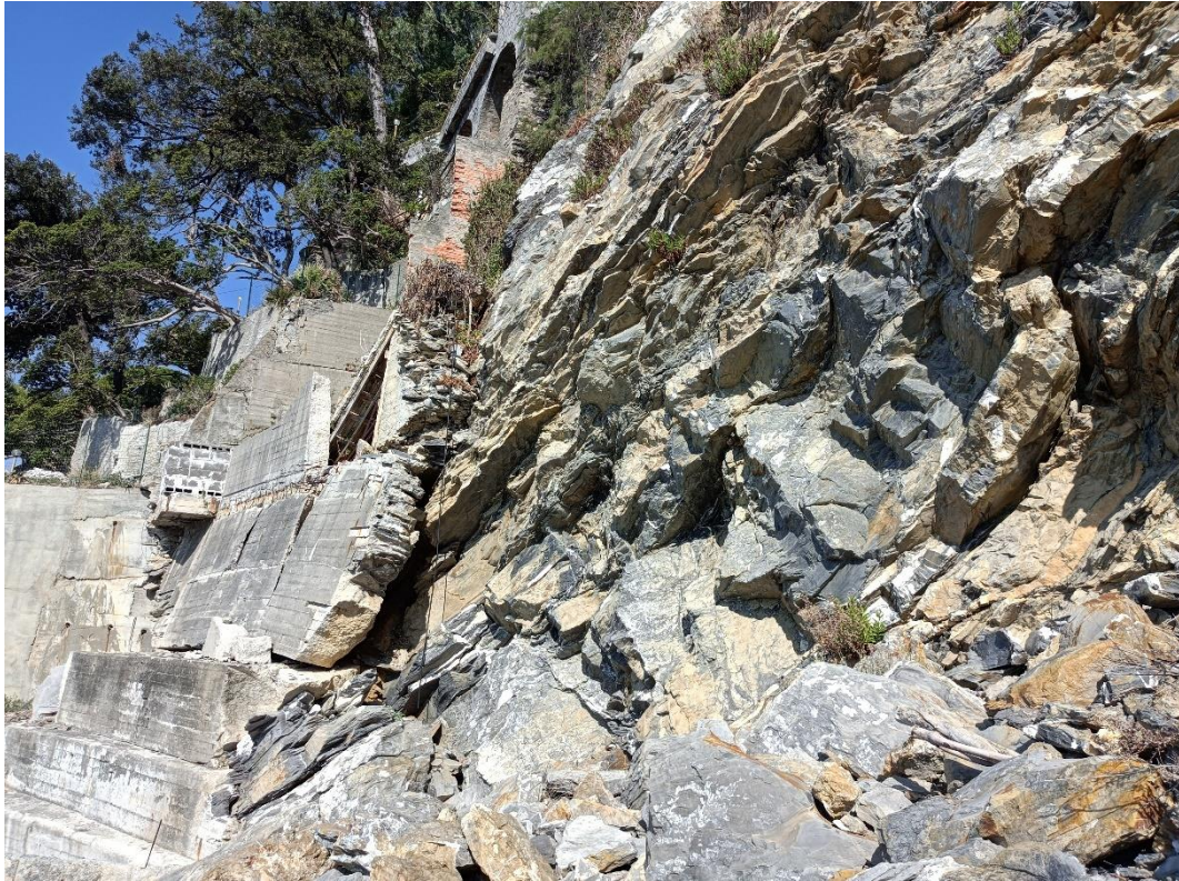
Foto 11: Vista laterale dei muri in cemento armato a Ovest della frana.
