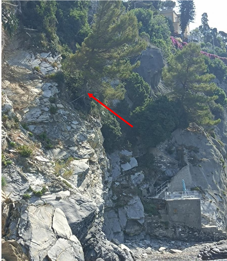
Foto 15: Bancate rocciose a Est della frana. La freccia indica un albero in precarie condizioni di stabilità.
