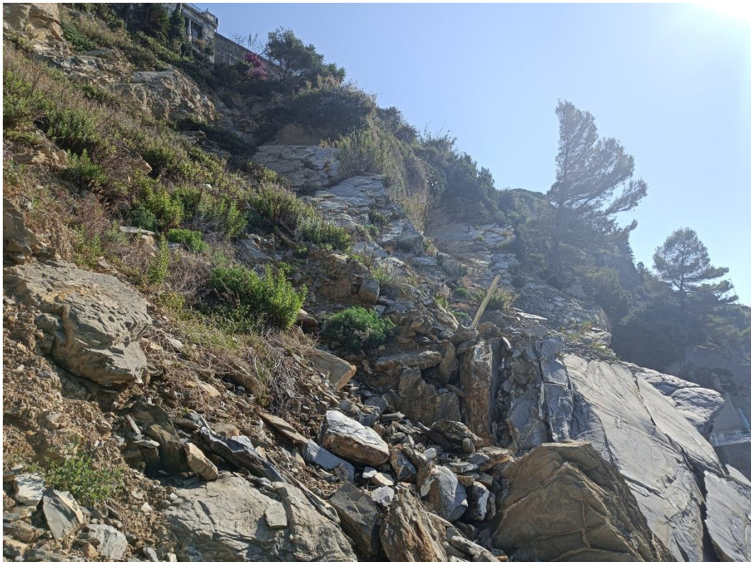
Foto 14: Accumulo detritico a monte del blocco roccioso visibile nella foto precedente.
