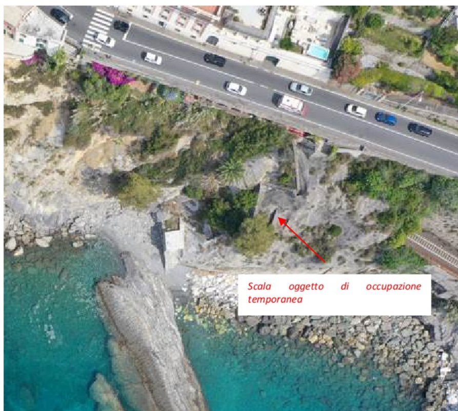
Foto 8.1: foto del mappale [REDACTED] con indicazione della scala oggetto di temporanea occupazione
