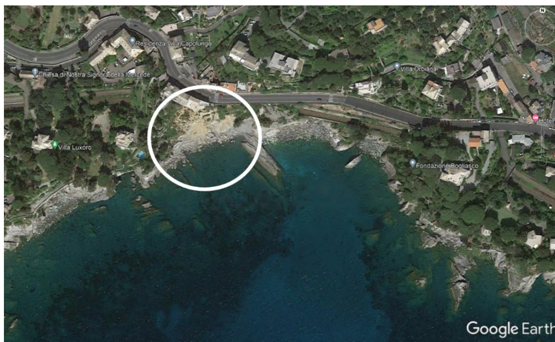
Figura 1-1 Sito oggetto di studio: nel cerchio bianco è evidenziata la zona interessata dalla frana del 2014
