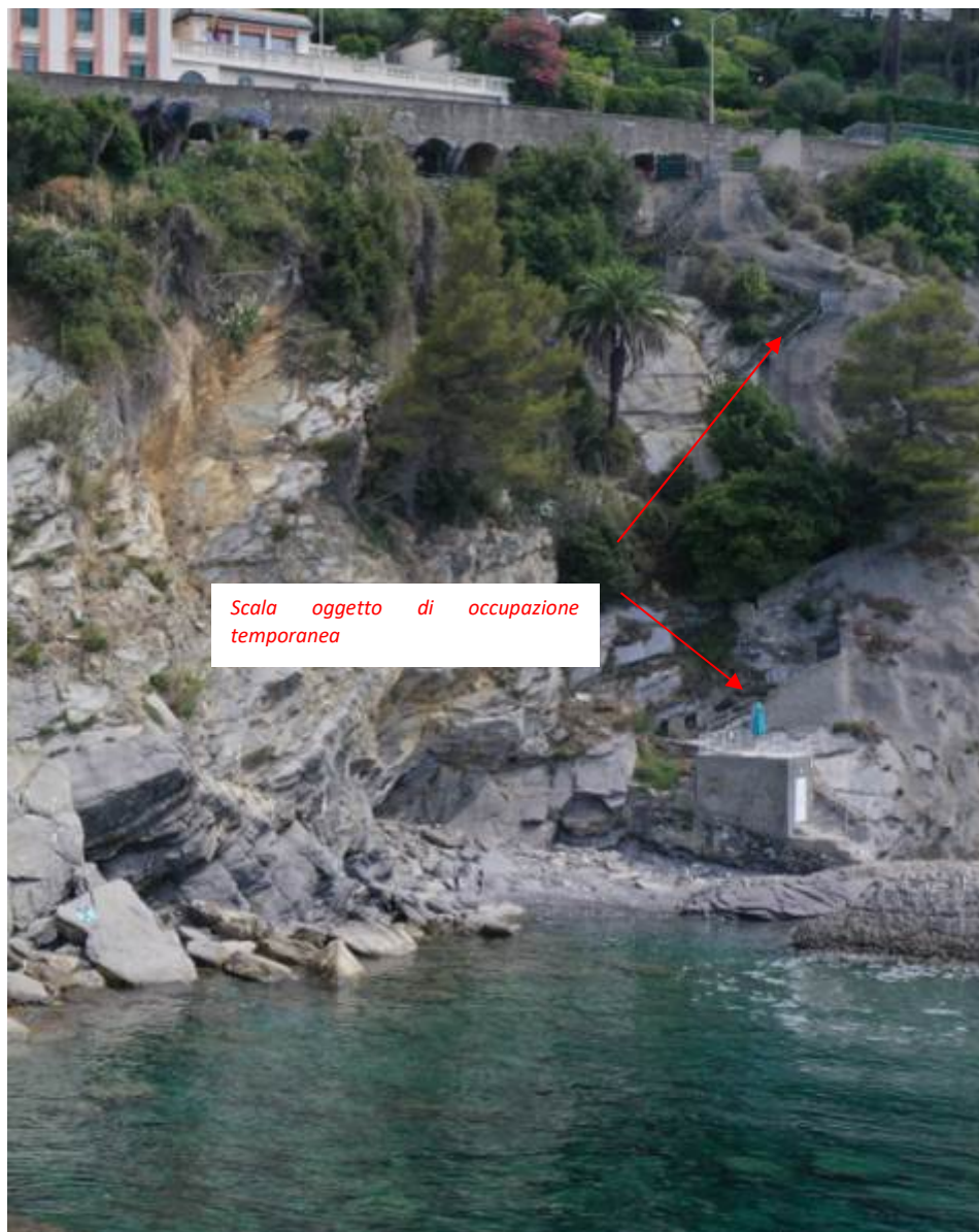
Foto 4.3: dettaglio dell'ubicazione della scala oggetto di temporanea occupazione
