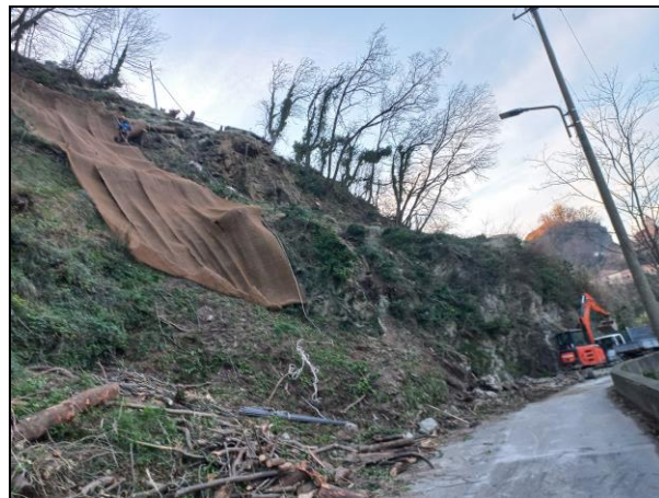
Figura 17: giovedì 11 gennaio. Al piede continuano le operazioni di sgombero e pulizia. Alle ore 13.00 è stata ripristinata la circolazione a senso unico alternato con impianto semaforico.
