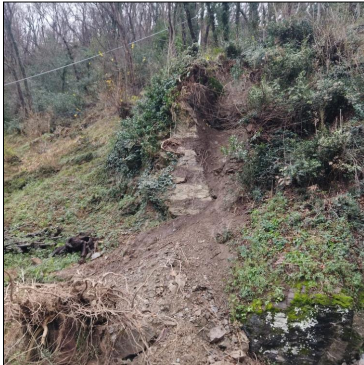
Figura 5: domenica 7 gennaio. Nicchia di distacco della frana in roccia alterata
