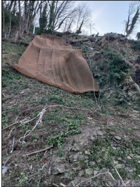
Figura 16: giovedì 11 gennaio. In corso la stesa delle reti metalliche in parete. Al piede continuano le operazioni di sgombero e pulizia. Alle ore 13.00 è stata ripristinata la circolazione a senso unico alternato con impianto semaforico.
