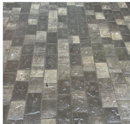
Foto 20 - Particolare pavimentazione in variante
