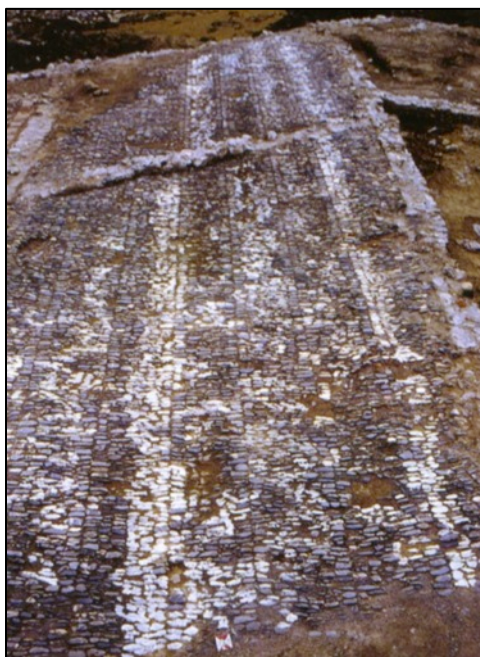
Fig. 17. Piazza Vittoria: tratto di strada del XIII secolo (da Gardini, 2001, p. 120)
