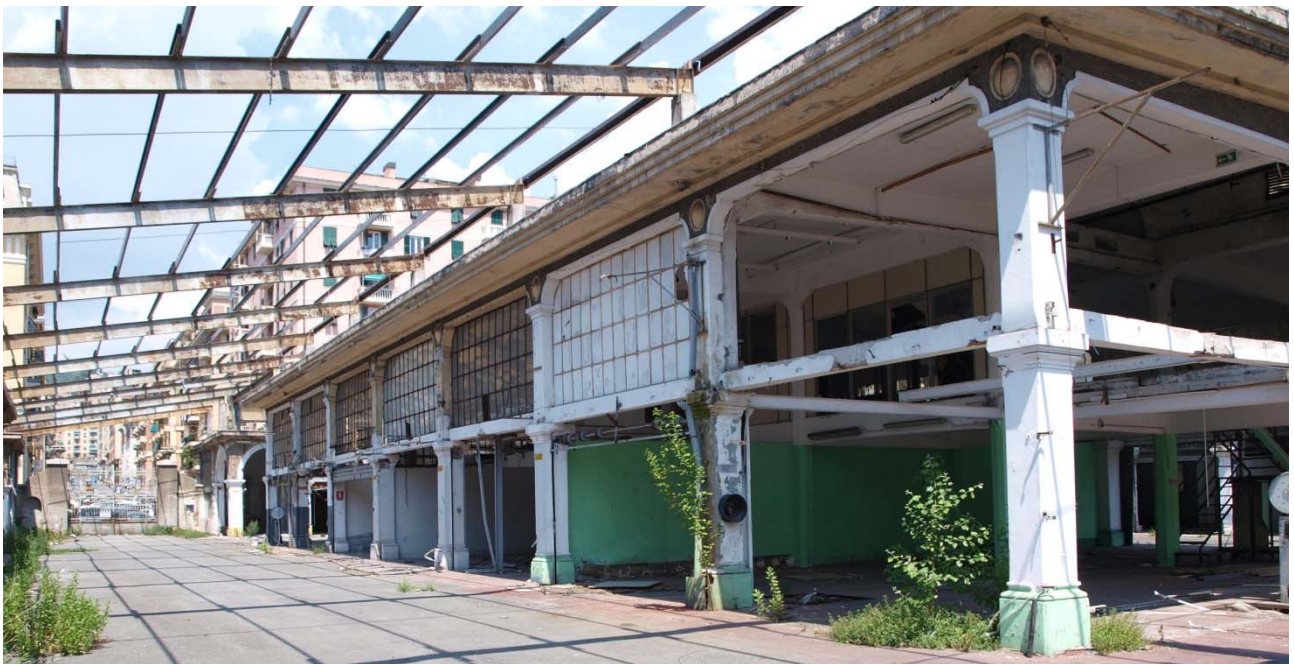
Foto stato attuale interna al mercato_padiglioni interni
