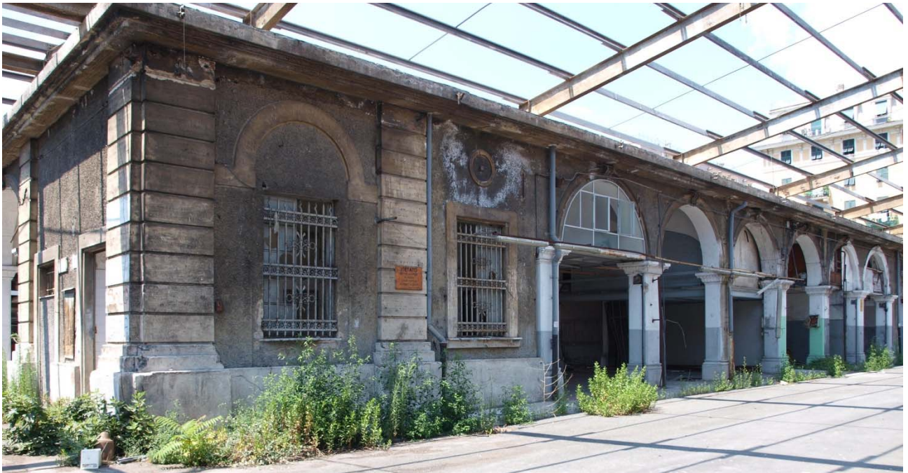
Foto stato attuale interna al mercato_padiglioni interni
