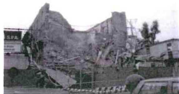
Immagine del crollo della testata ovest (1993)
