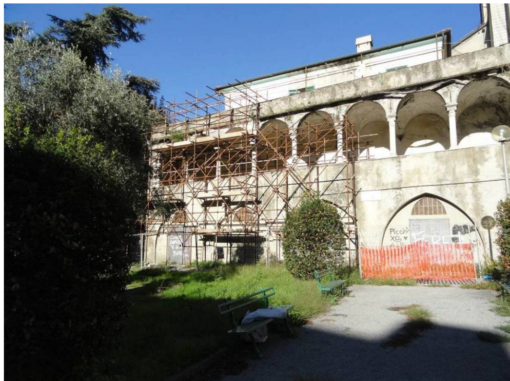
Vista della zona interessata dall'intervento (foto tratta dalla relazione di progetto)
