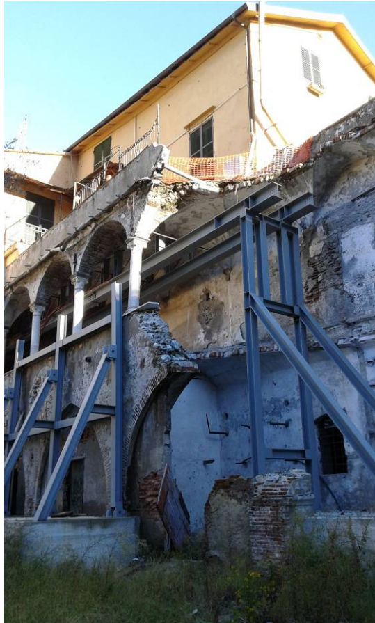
Vista della porzione centrale del Chiostro: evidente l'intervento realizzato per la messa in sicurezza
