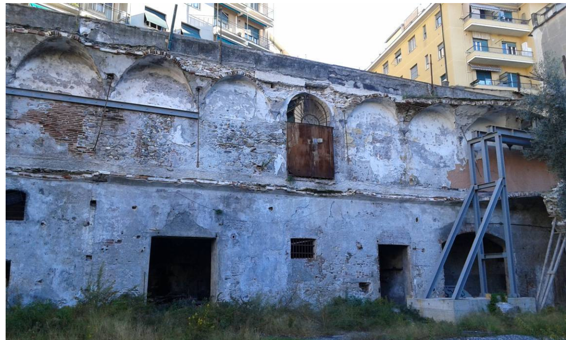
Vista della porzione centrale del Chiostro: evidente l'intervento realizzato per la messa in sicurezza
