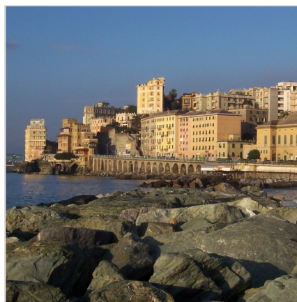
Veduta verso Capo Risveglio
