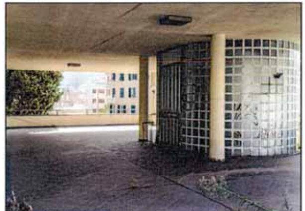
Vista 5 – Particolare della scala in vetrocemento
