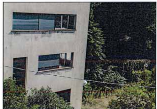
Vista 4 – Particolare dei piani sottostrada
