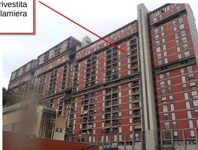
Figura 7 Facciata ovest Diga rossa
