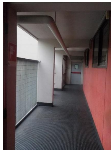
Figura 14 Corridoio Diga rossa
