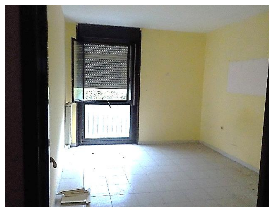
Figura 16 Alloggio Diga rossa
