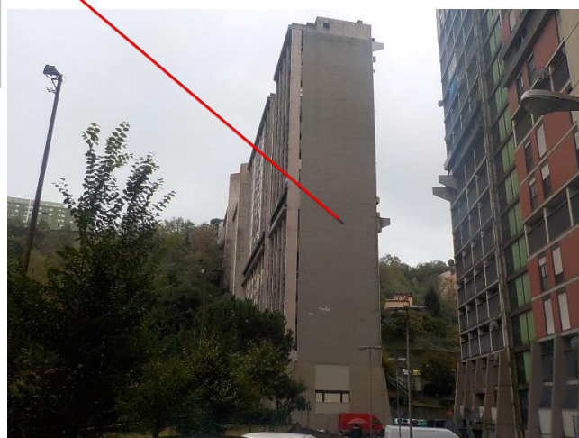
Figura 6 Facciata sud Diga rossa
