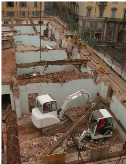
Minimacchine operanti al piano in quota
