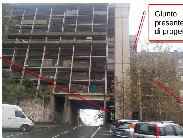
Figura 5 – Giunto tecnico Diga bianca
