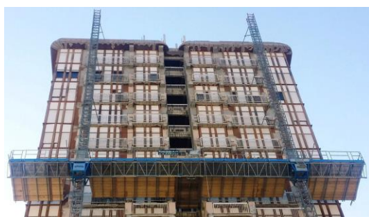
Esempio di ponteggio autodiscendente
