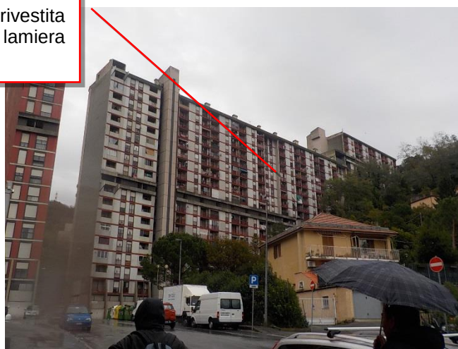
Figura 9 Facciata ovest Diga bianca
