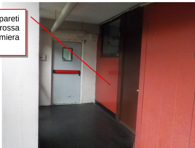
Figura 8 Particolare parete Diga rossa
