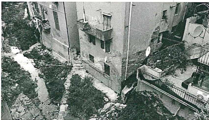
Foto 5 – Stato dei luoghi
