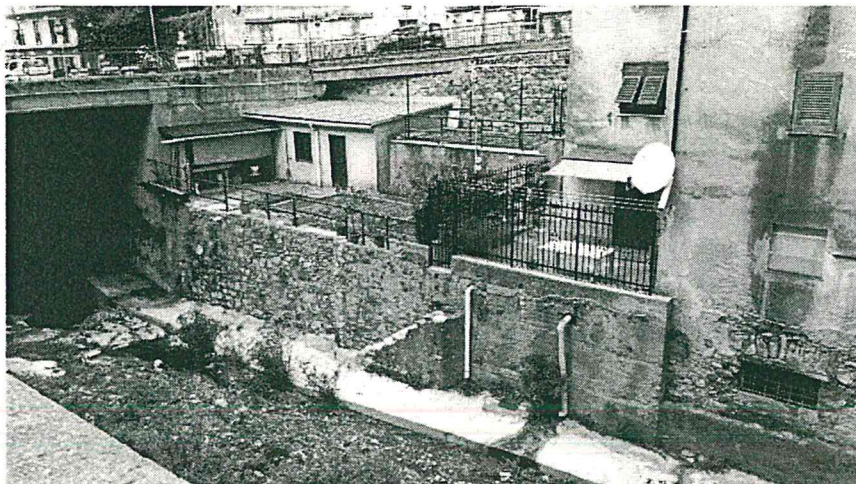
Foto 1 – Stato dei luoghi
