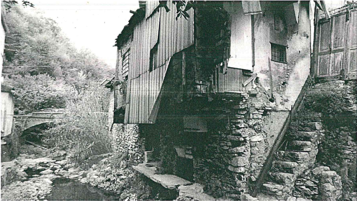
Foto 3: Stato dei luoghi
