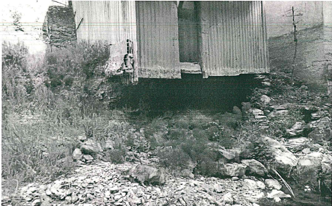
Foto 5: Stato dei luoghi
