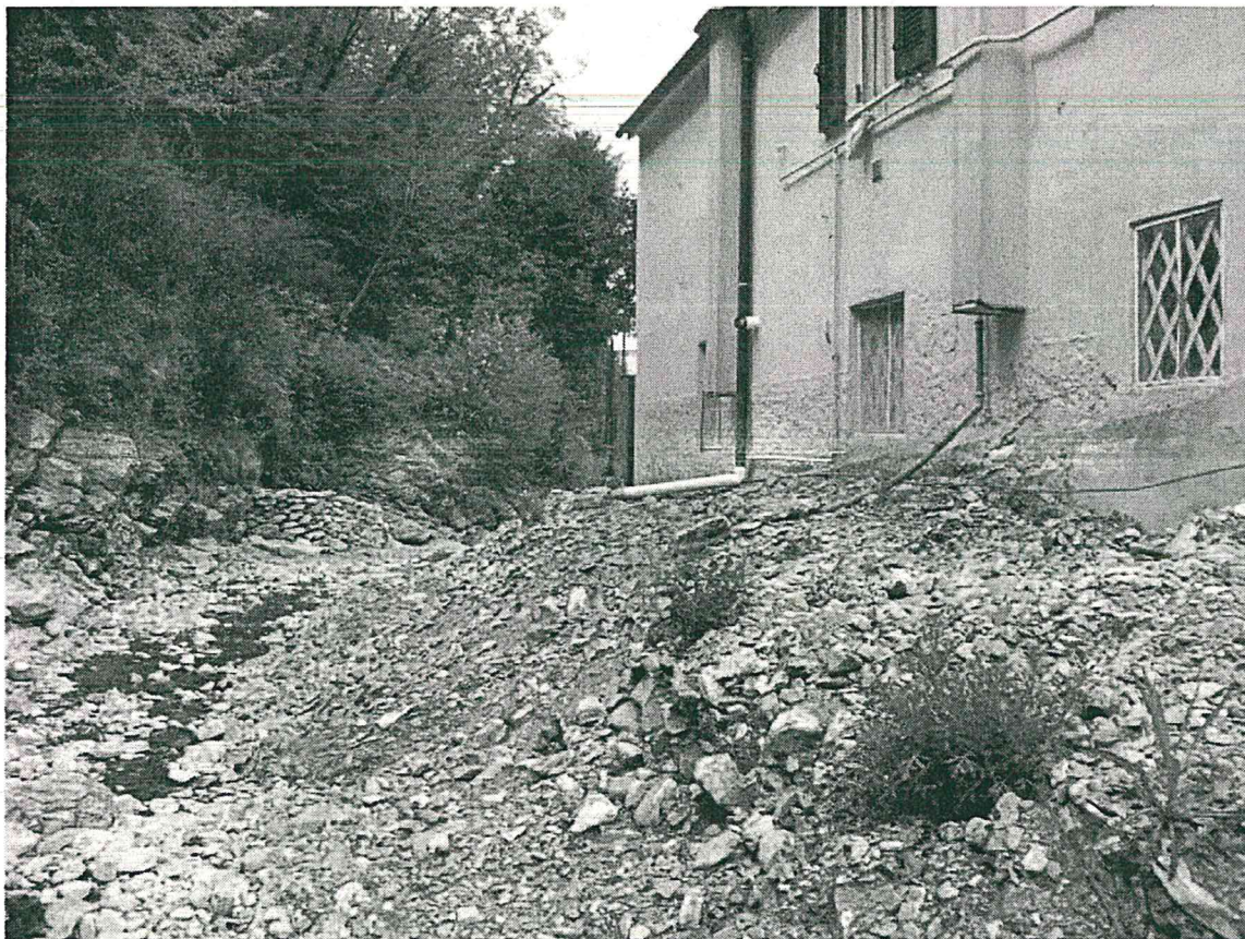
Foto 10: Stato dei luoghi
