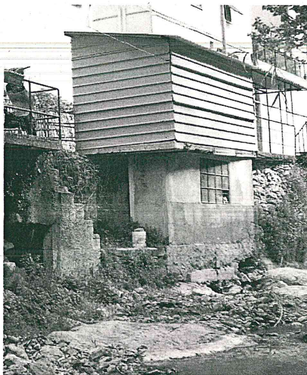
Foto 4: Stato dei luoghi
