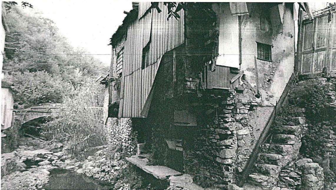
Foto 2: Stato dei luoghi
