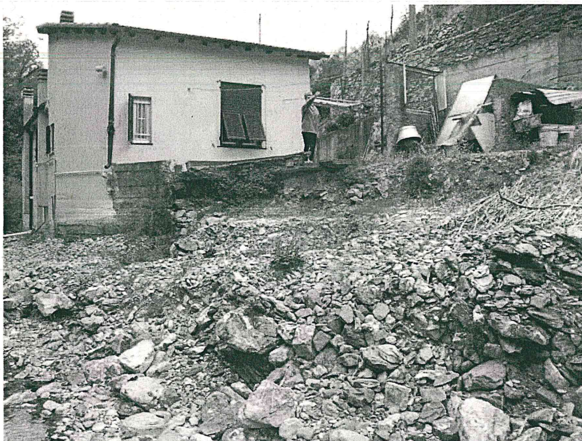
Foto 8: Stato dei luoghi
