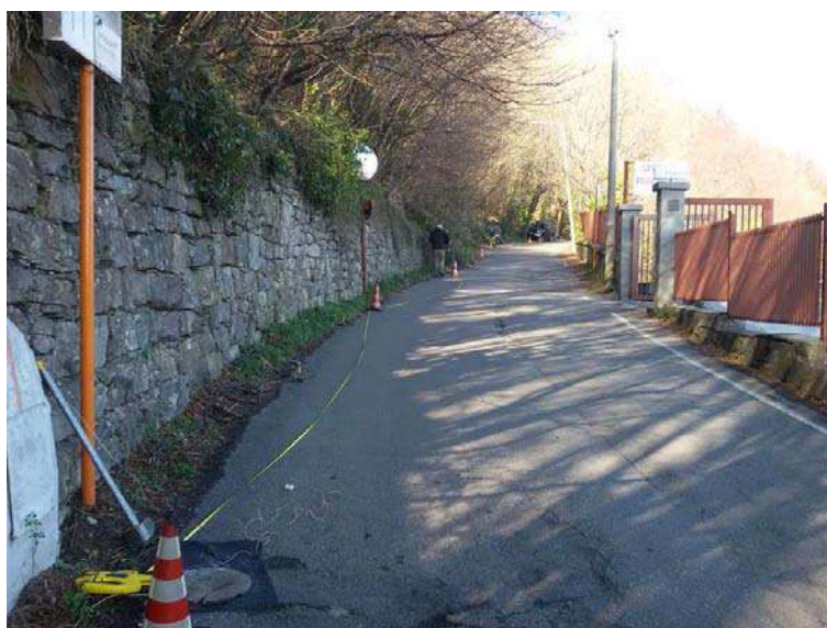
Stendimento sismico tomografico SS1, estremo iniziale (mazza e piastra in offset lato geofono G1)
