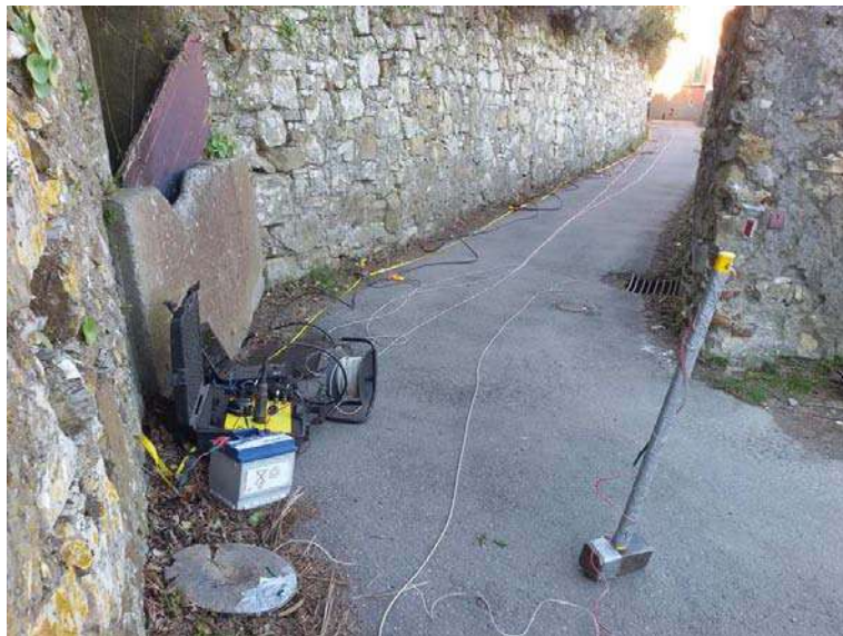
Stendimento sismico tomografico SS4, estremo iniziale (mazza e piastra in offset lato geofono G1)
