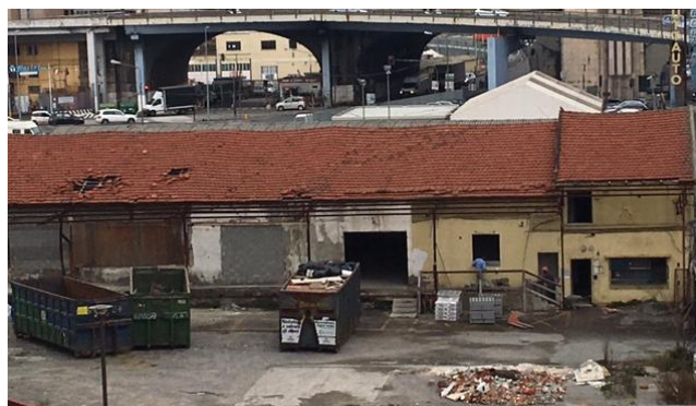
- VISTA DI DETTAGLIO DEL PROSPETTO DI LEVANTE -
