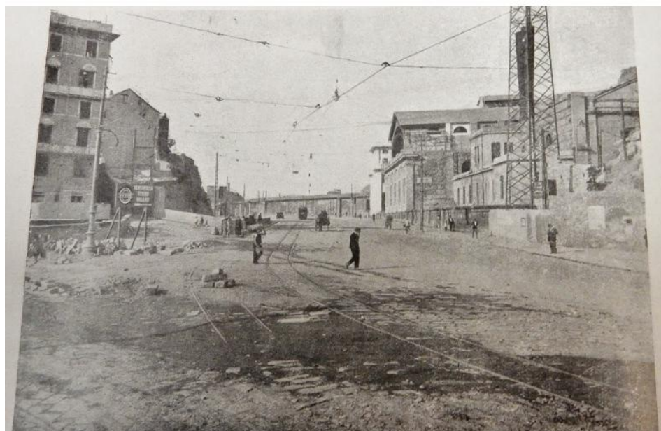
Immagine del 1929 con i lavori praticamente ultimati visti da via Milano.
