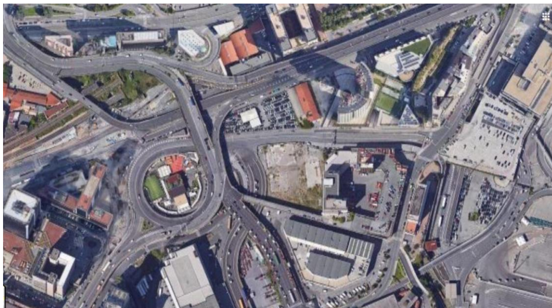
- VISTA AEREA GENERALE -
