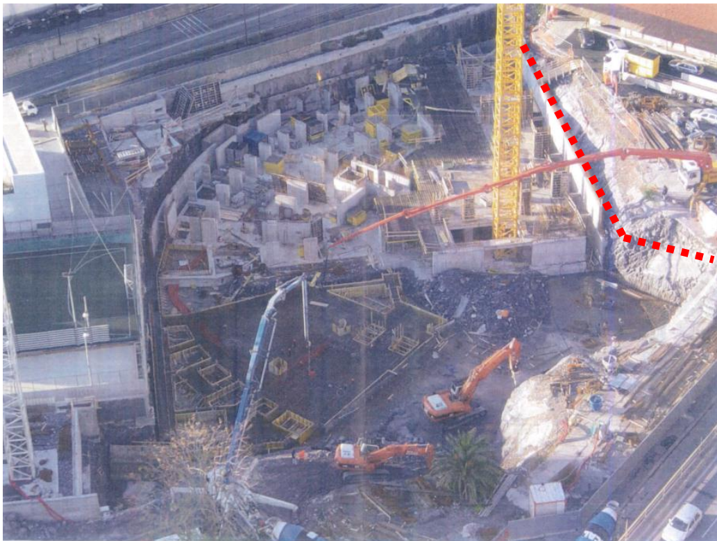
- VISTA DEL CANTIERE "TORRI FARO" DURANTE LA REALIZZAZIONE DELL'AUTORIMESSA INTERRATA ■■■■■ IL PROFILO DEL CONFINE CON 1.1.1
