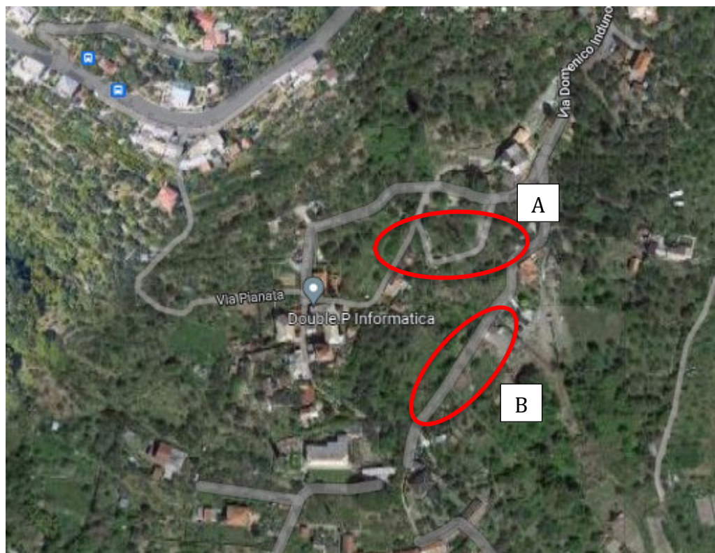
Figura 1 - foto aerea, con l'ubicazione dei siti oggetto di interventi urgenti: Intervento A ripristino funzionale di via stallo di bavari e intervento B ripristino di un tratto di via Induno. (Google Earth).
