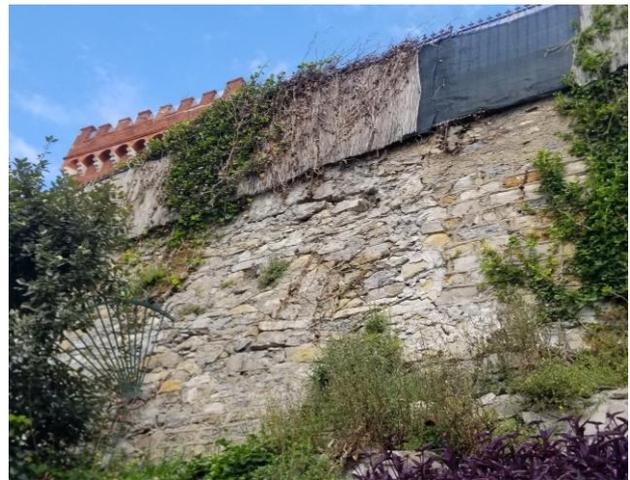
Figura 8-9 – Particolari delle lesioni riscontrate sul muro di sostegno
