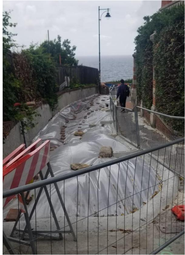
Figure 6-7 – Transennamento provvisorio con opere di mitigazione (telo protettivo e relativo cordolo).
