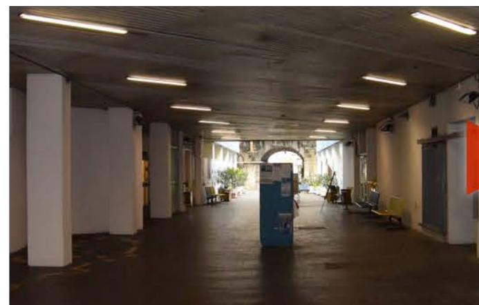
INTERVENTO SULLA GALLERIA CENTRALE
