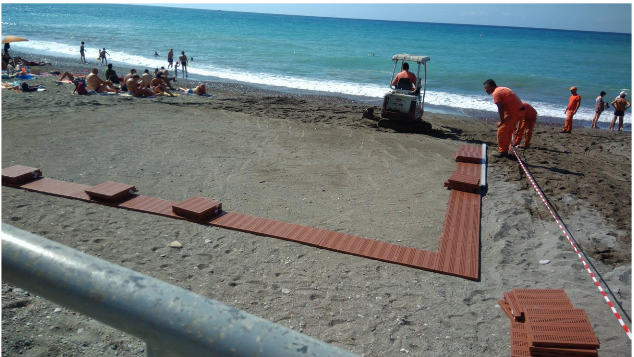
Installazione pannellature ad incastro in PVC (dim. 100x100 cm.) - anno 2021
