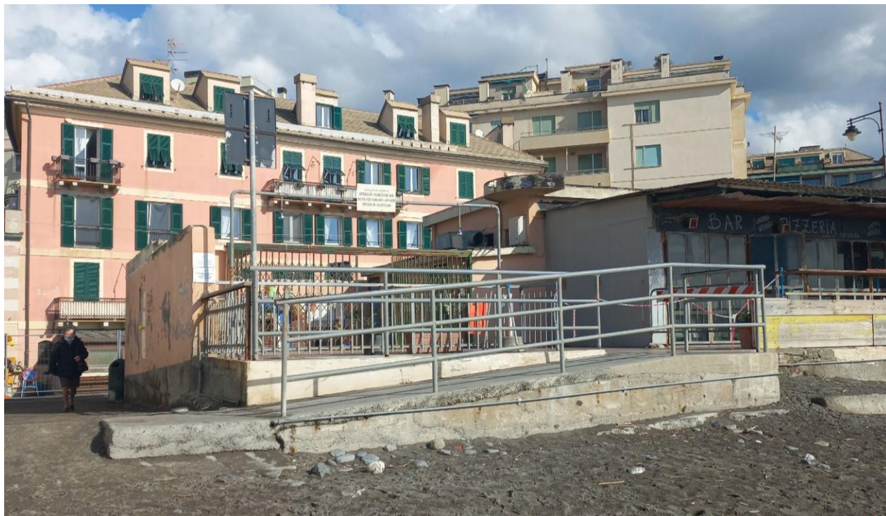
Accesso a blocco servizi e docce con rampa (pendenza 7%)
