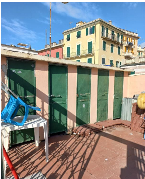
Blocco servizi (lato ponente)
