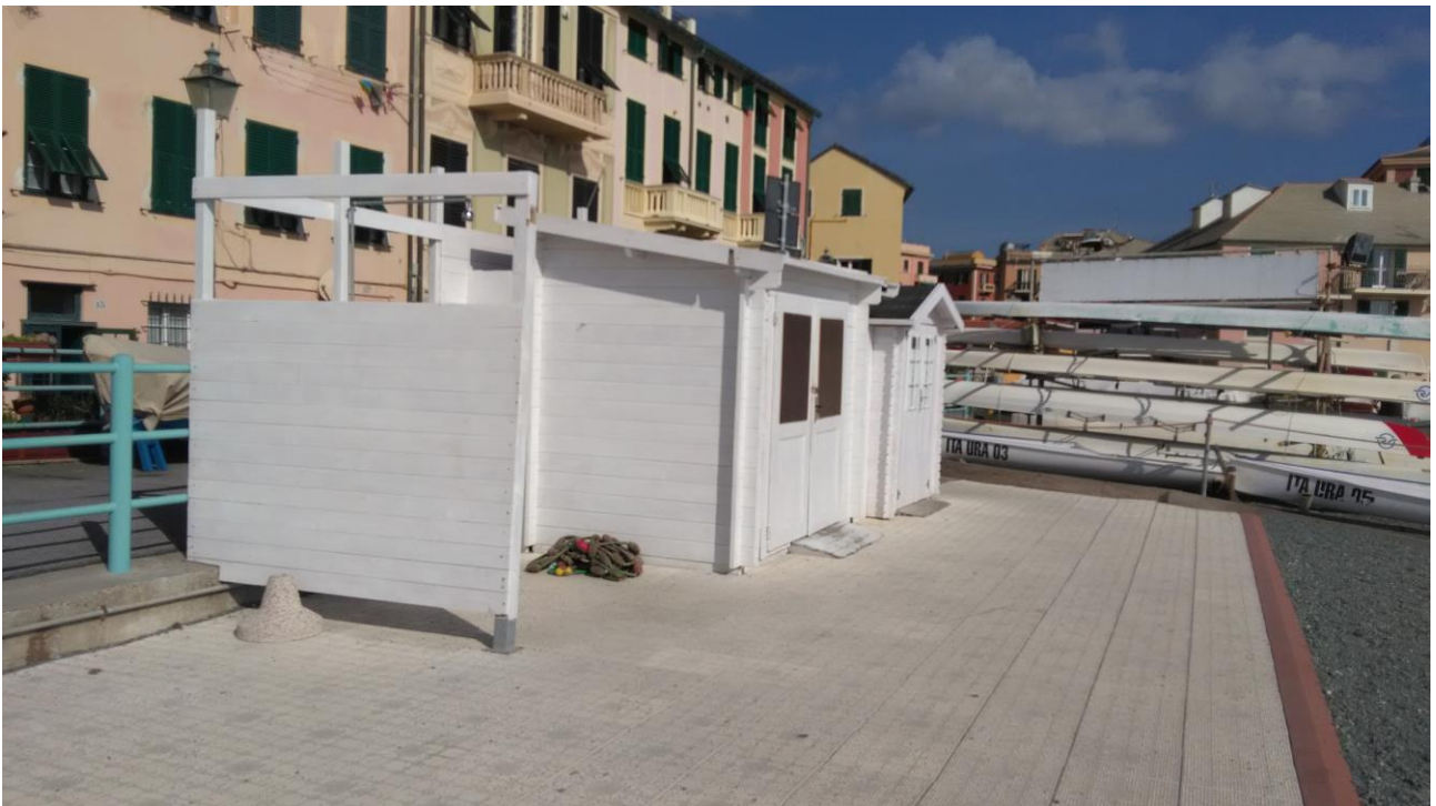
Piattaforma polifunzionale in pannellature removibili ad incastro in PVC
