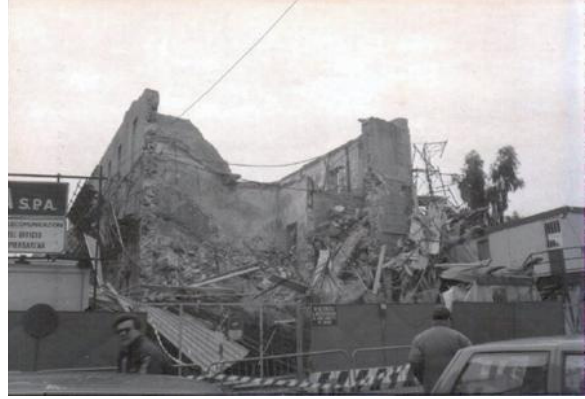
Immagine del crollo della testata ovest (1993)
