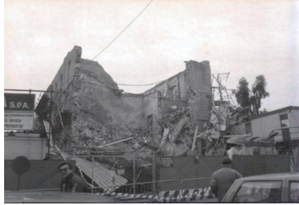
Immagine del crollo della testata ovest (1993)
