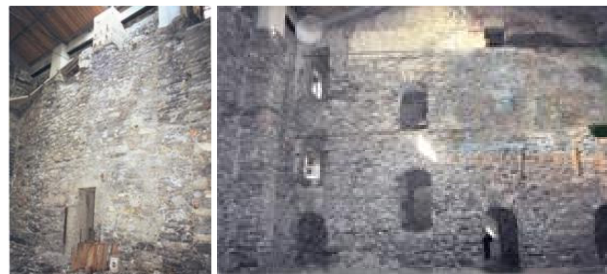
Interno dei magazzini anni '90
