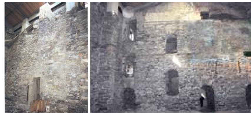
Interno dei magazzini anni '90
