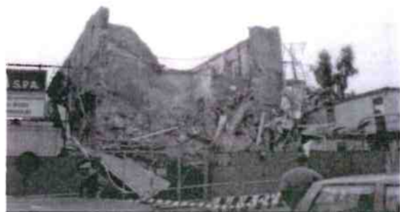
Immagine del crollo della testata ovest (1993)
