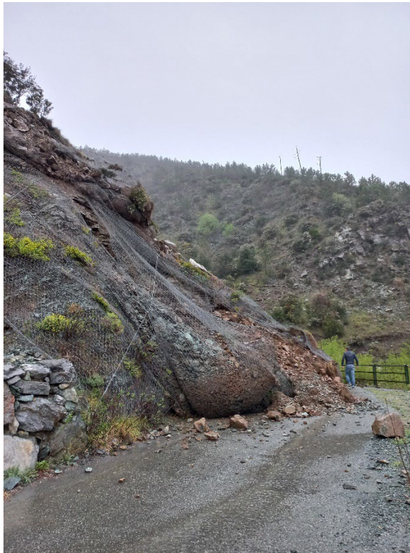
Figura 6: collasso della parete rocciosa con strappo della retatura ed ostruzione parziale della carreggiata di Via Sant'Alberto (vista verso nord)
