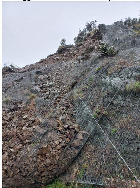
Figura 9: particolare dello strappo e del riempimento della rete presente in loco
