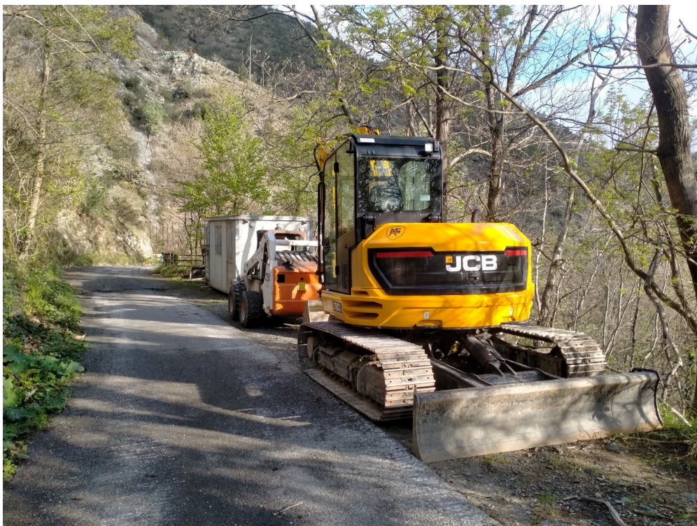
Figura 11: primi mezzi in cantiere al 19 aprile 2023
