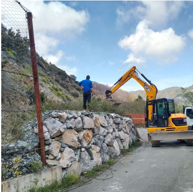
Figura 12: primi interventi di rimozione elementi disarticolati
