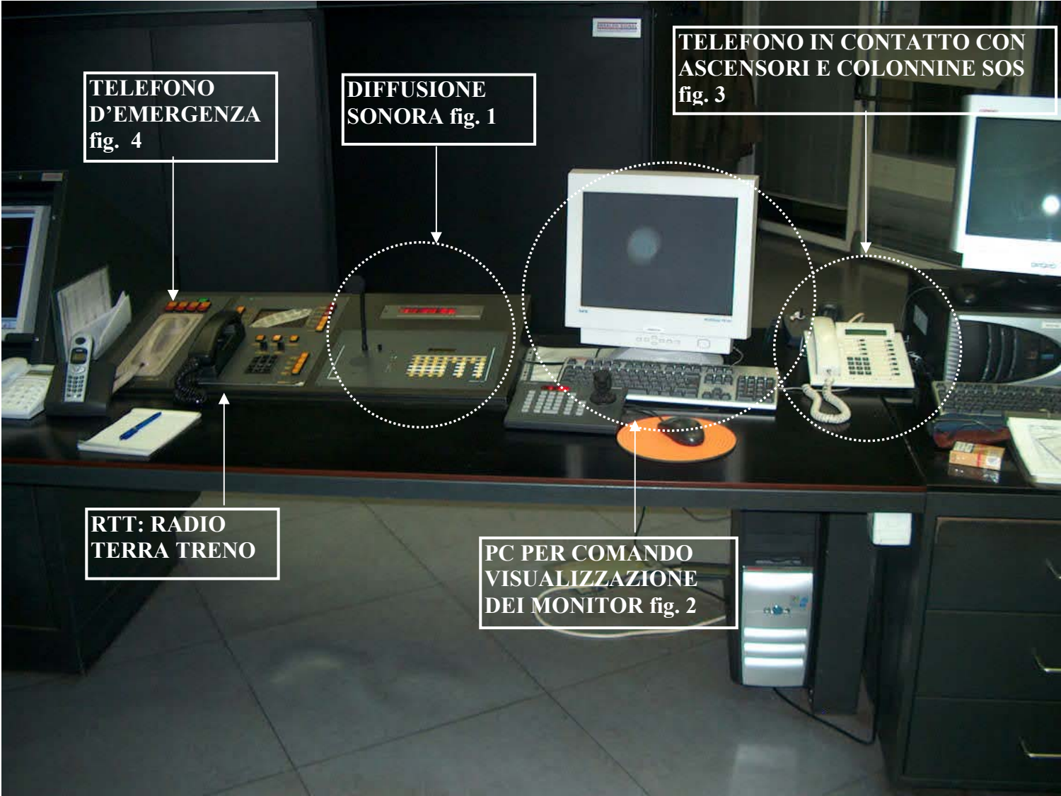
fig. 5 VISIONE D'INSIEME DEL BANCO DCT
