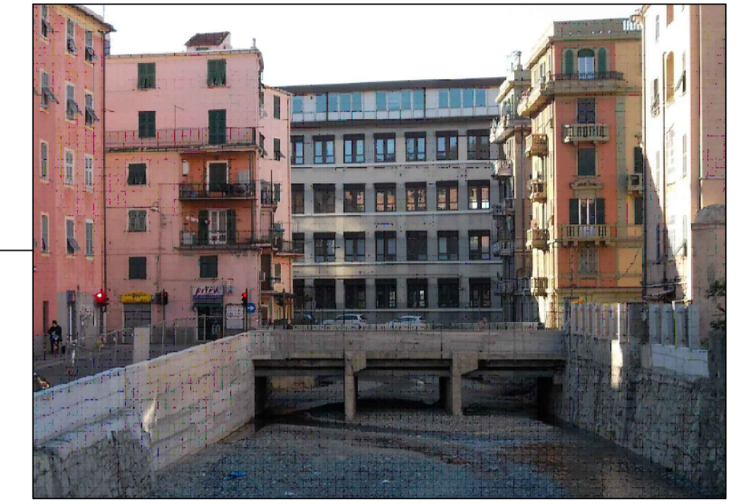
CIVICO 15 DI VIA GIOTTO A FINE LAVORI
