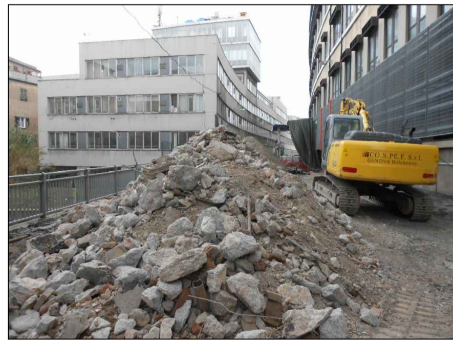
DEMOLIZIONE PONTE MANARA
