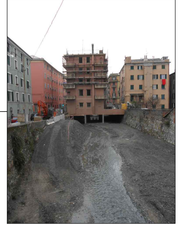
CIVICO 15 DI VIA GIOTTO PRIMA DELLA DEMOLIZIONE
