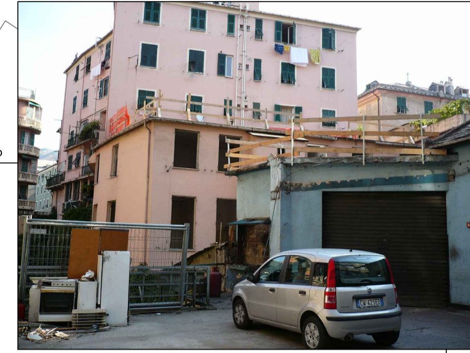
CIVICO 20 VIA GIOTTO PRIMA DEI LAVORI
