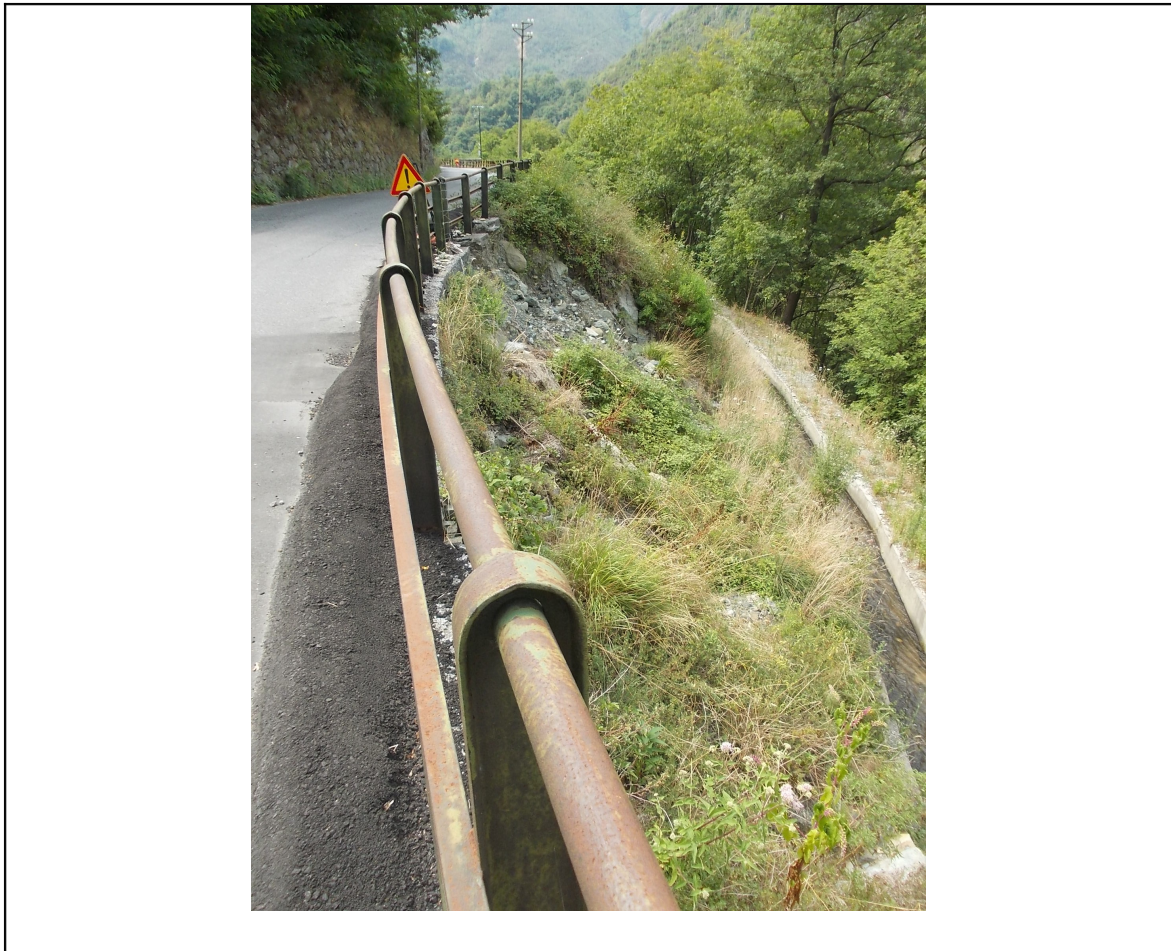
Vista scarpata a valle sede stradale
