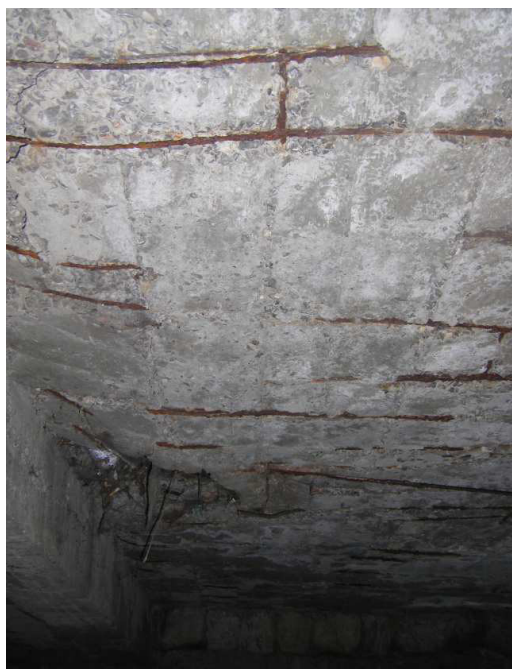
Fig 36- Cedimento dell'impalcato
