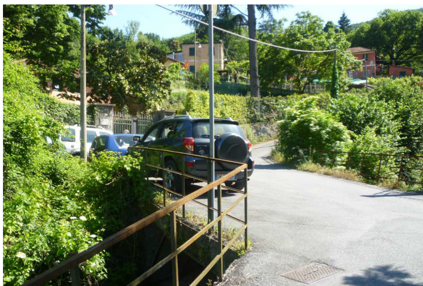
Fig.12 – Vista del ponte Comunale
