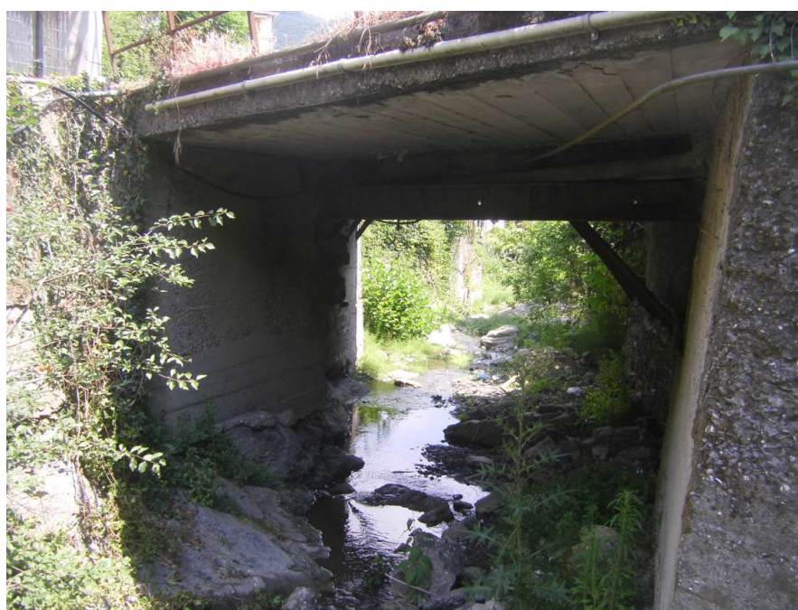
Fig.13 – Vista intradosso del ponte Comunale
