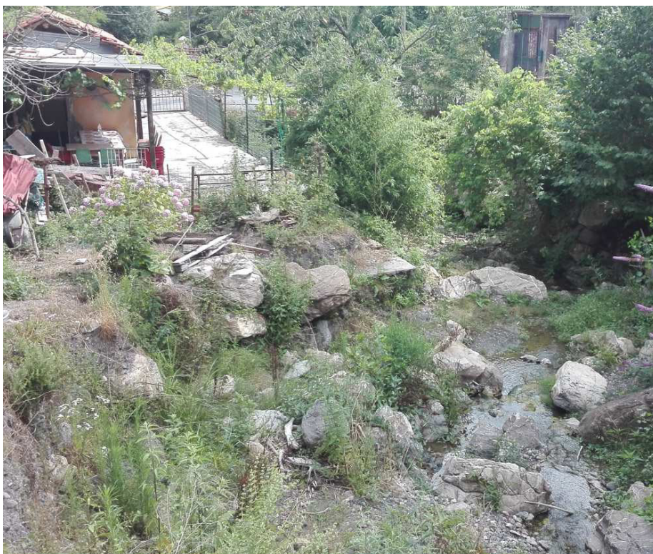
Fig.14 – Terrazzamento privato mappale 238 su sponda sinistra
