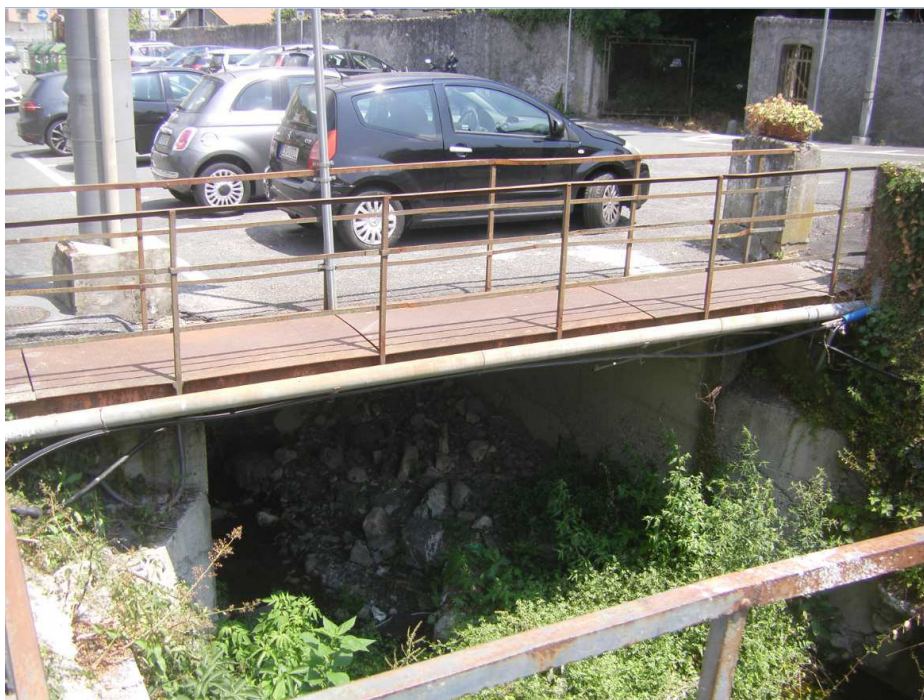
Fig 32- Imbocco della tombinatura
