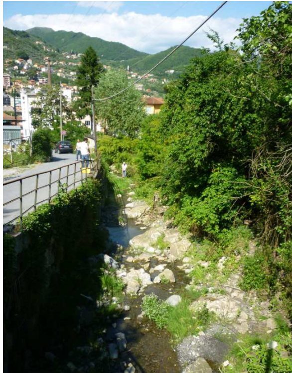
Fig 18- vista della sponda sinistra verso la strada Comunale
