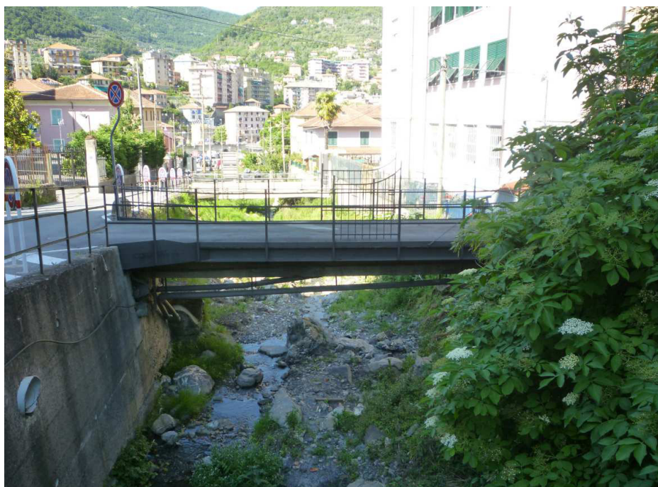
Fig 21- 2° Attraversamento privato da monte
