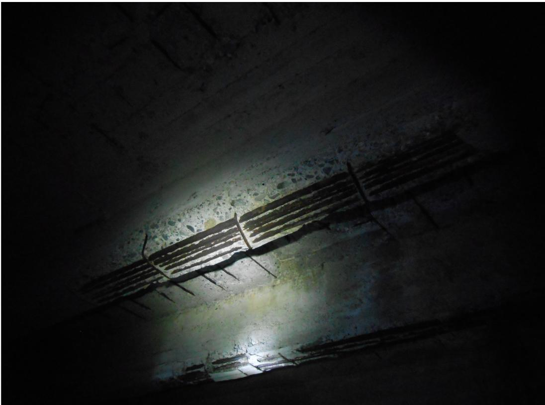
Foto 6: RIO VEILINO – Stato di conservazione travi ribassate della copertura
