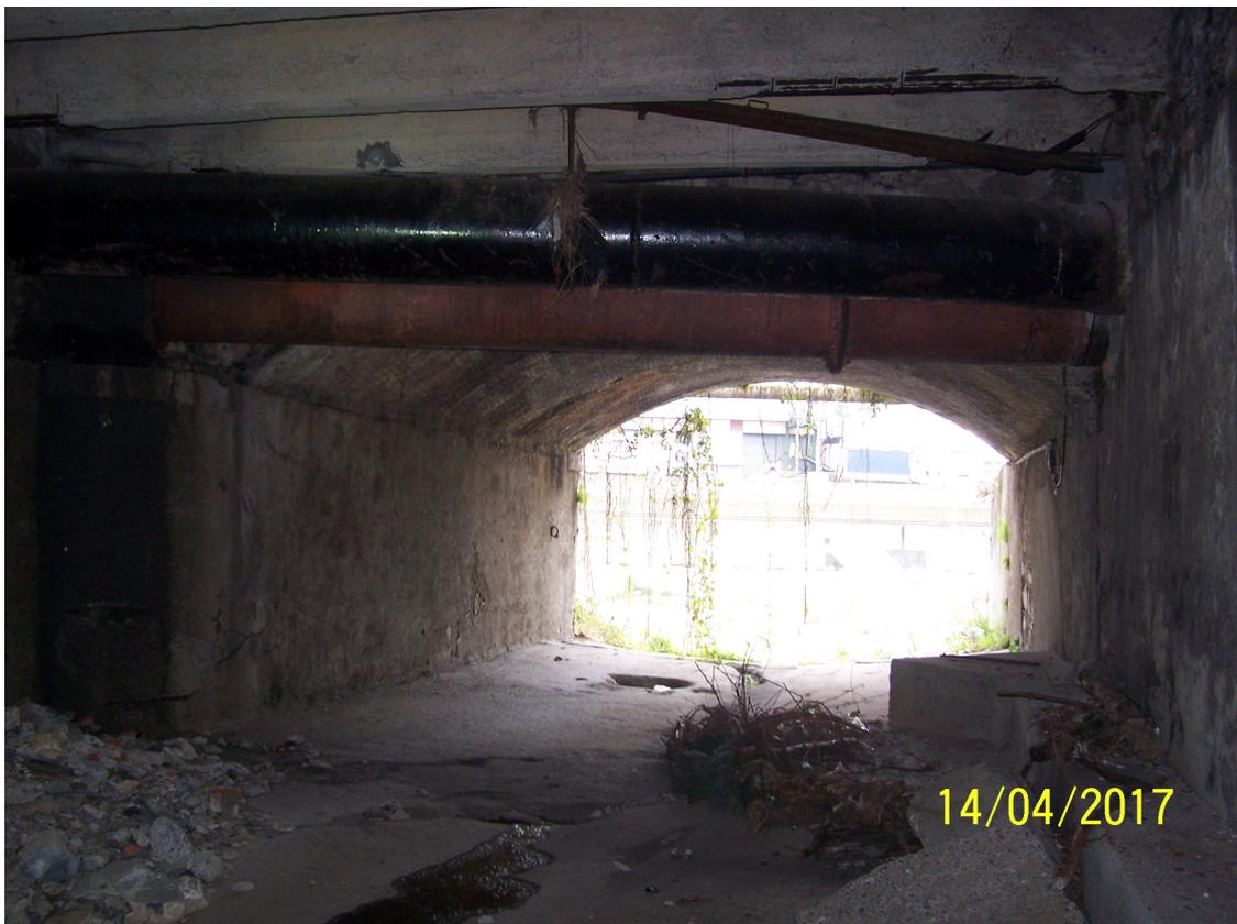
Foto 18: RIO VEILINO – Ponte in muratura sotto Via Piacenza e condotte gas diam. 600-650 mm
