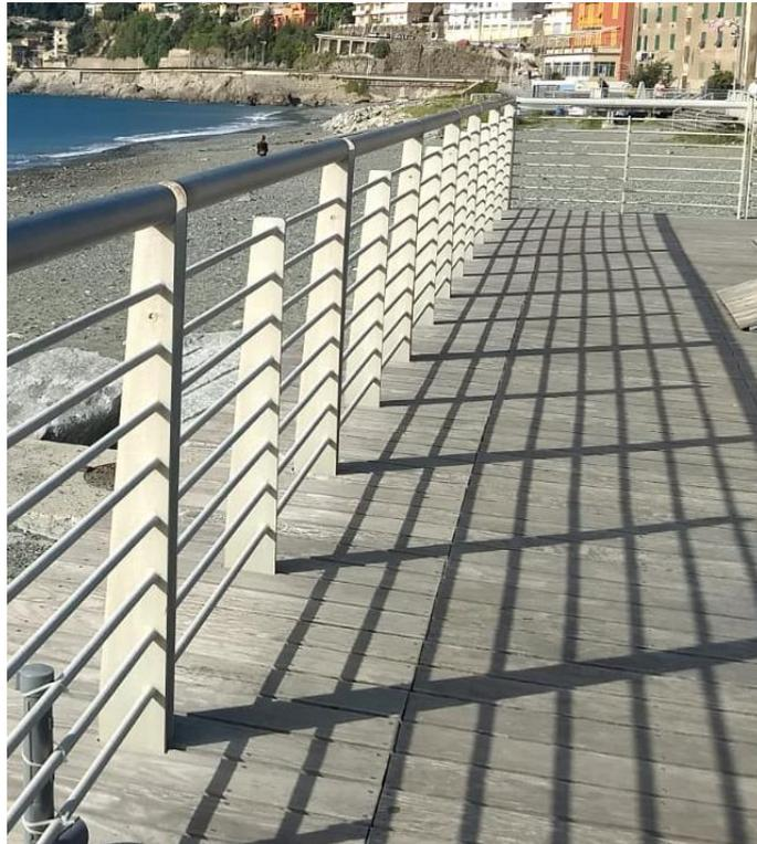
Nell'immagine qui sopra (Passeggiata di Voltri) si identifica un esempio di ringhiera e pavimentazione in legno realizzate e comparabili con quanto a progetto. La foto riporta un intervento già realizzato per cui simula realisticamente i colori che la nuova scala potrebbe assumere nel corso del tempo.
