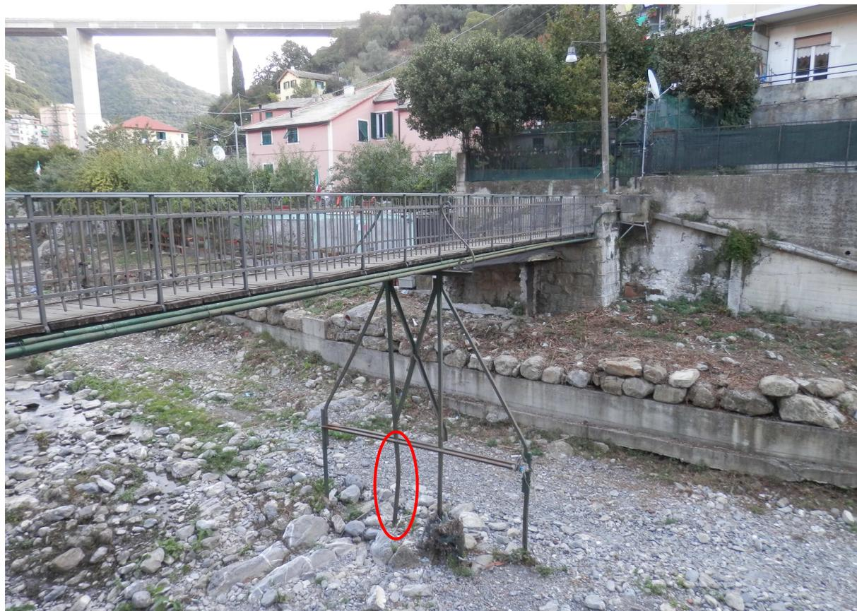
**Foto 3 – Particolare pila danneggiata**
