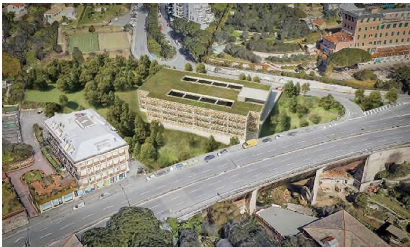
Figura 5.7-2: Vista area della copertura verde del tetto dell’edificio
