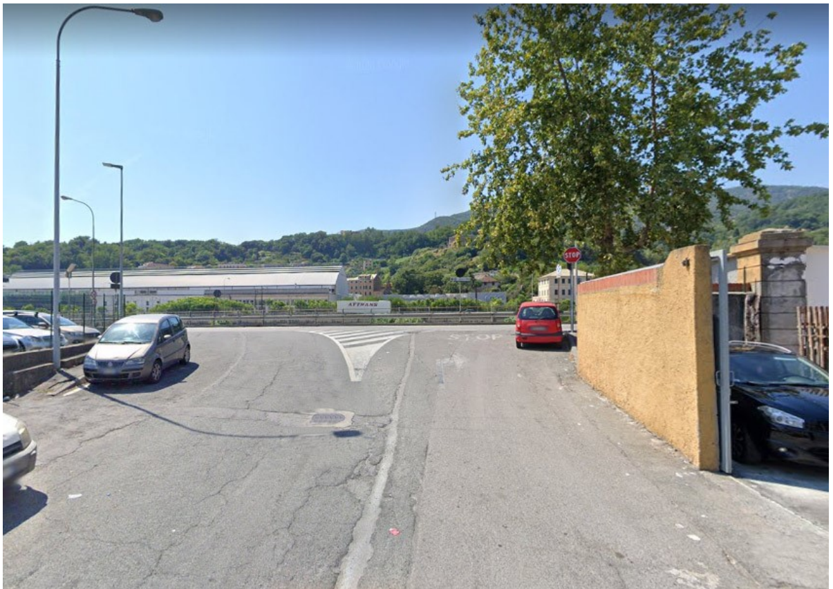
Uscita di raccordo su via Perlasca, strada di sponda sinistra del torrente Polcevera realizzata di recente.
