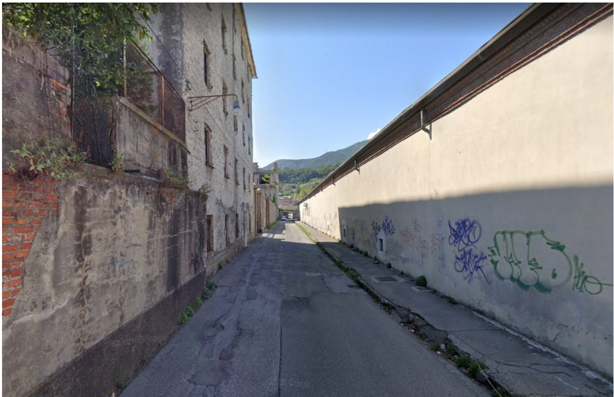
Fronte edificato lungo via Lepanto. Gli ingressi presenti sono posti solo sul lato dell'area ex Mira Lanza, lasciando il fronte del fabbricato di destra completamente cieco e privo di ingressi. Tale disposizione dichiara un utilizzo esclusivo da parte del complesso industriale con conseguente transito dei soli mezzi ad esso afferenti. Il sottopasso della ferrovia, di fatto, permette il transito anche alle autovetture ed è in utilizzo a questo scopo principalmente a seguito dell'apertura di via Perlasca.
