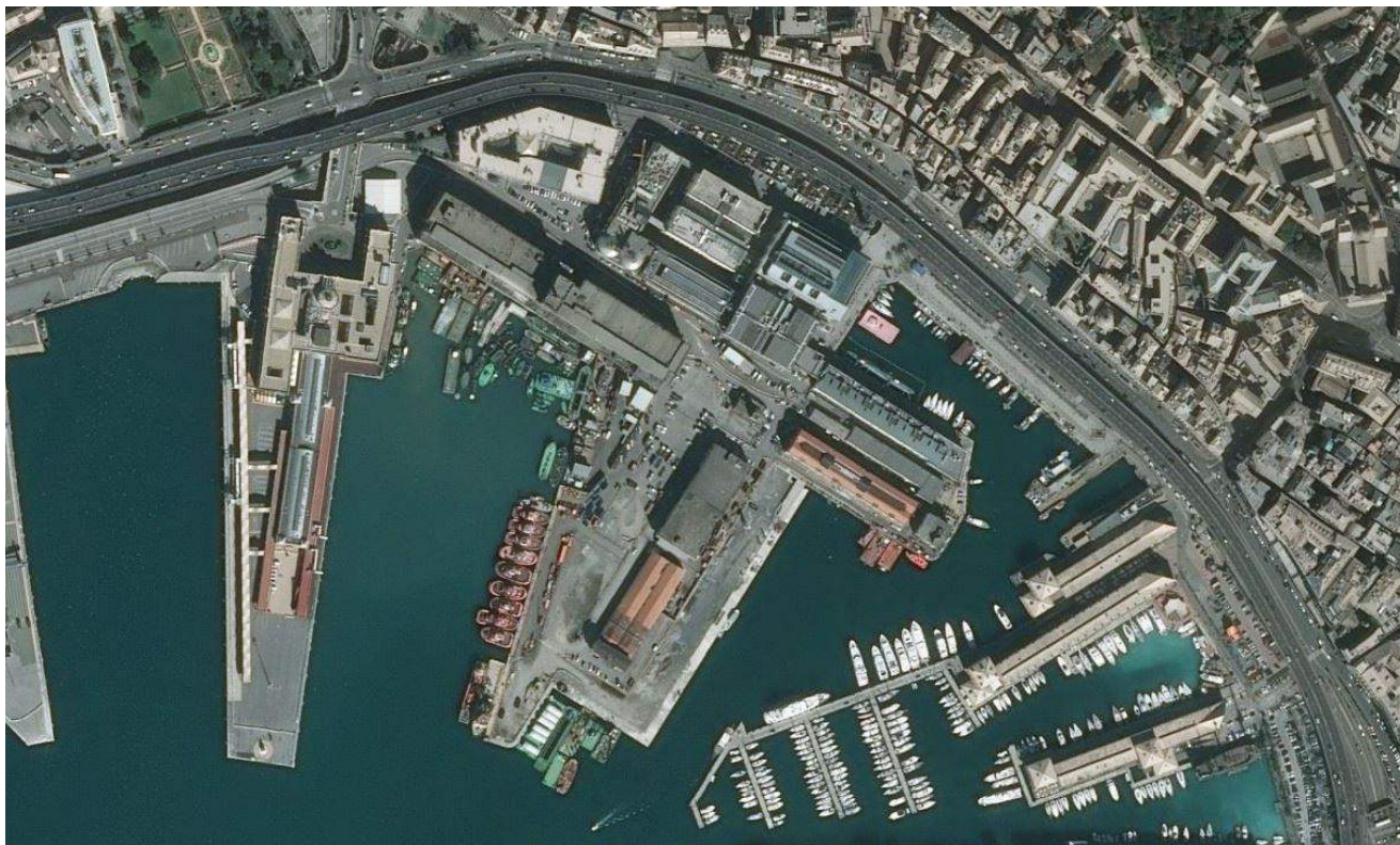
Vista aerea dell'area di Ponte Parodi
