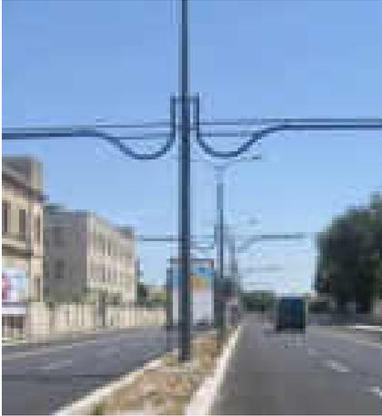
Trattasi della installazione dei pali di sostegno della linea elettrica per l'alimentazione del filobus.
