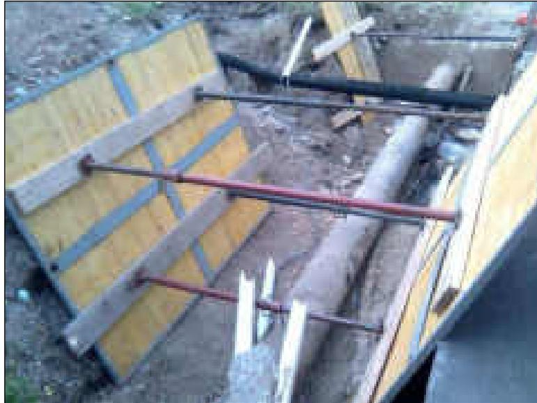
Esempio di armatura lignea vincolata da intelaiatura metallica. Notare la presenza di puntelli superiori ed inferiori, nonché degli assi ripartitori
