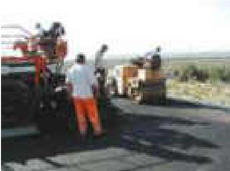
La fase di lavoro prevede l'asfaltatura del manto stradale formato da: conglomerato bituminoso (binder) e tappetino, stesi a caldo e di vario spessore. I vari strati sono stesi con vibrofinitrice, previo spandimento di bitume liquido su sottofondo già predisposto.
